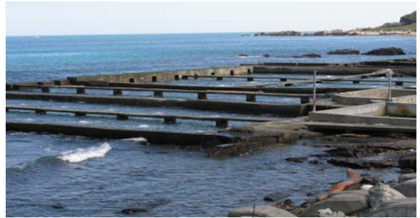
龍洞九孔養殖池
