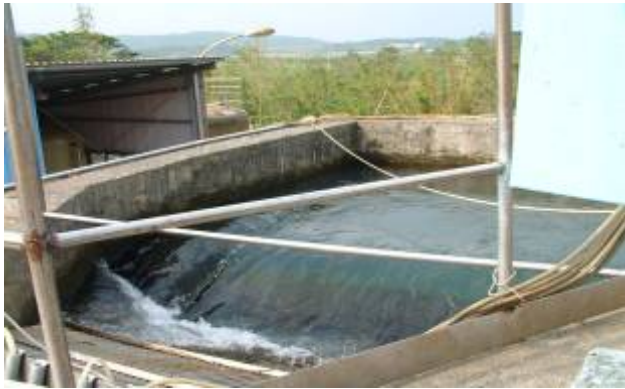
取樣點(自來水廠進水池)
