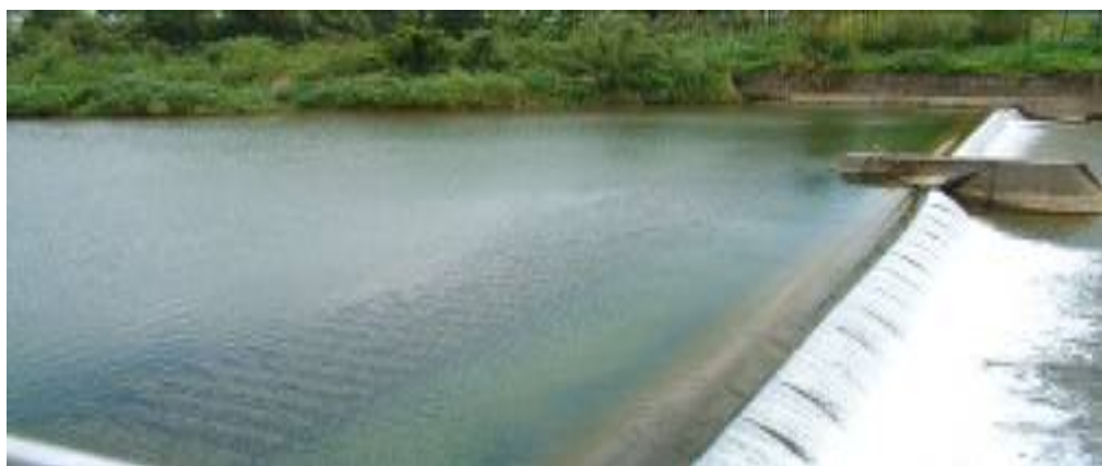
貢寮自來水廠水源壩
