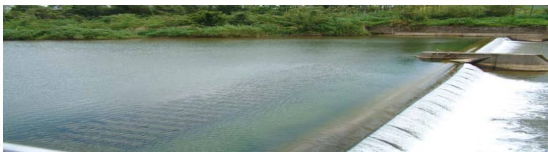
貢寮自來水廠水源壩
