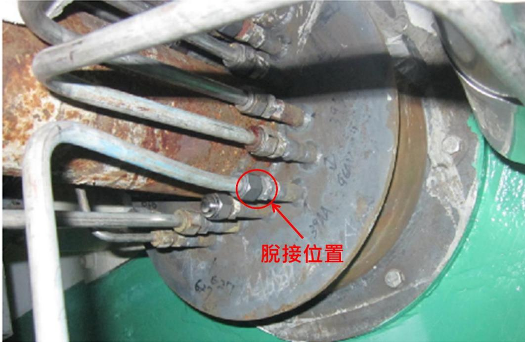
圖六、事故後取樣系統旁支管路(39AA)之脫接位置示意圖(圖為已修復狀態)
