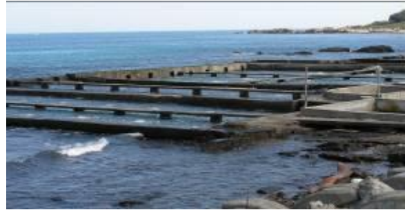
龍洞九孔養殖池
