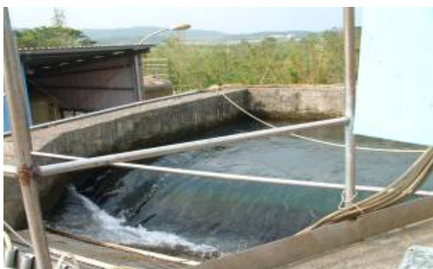
取樣點(自來水廠進水池)
