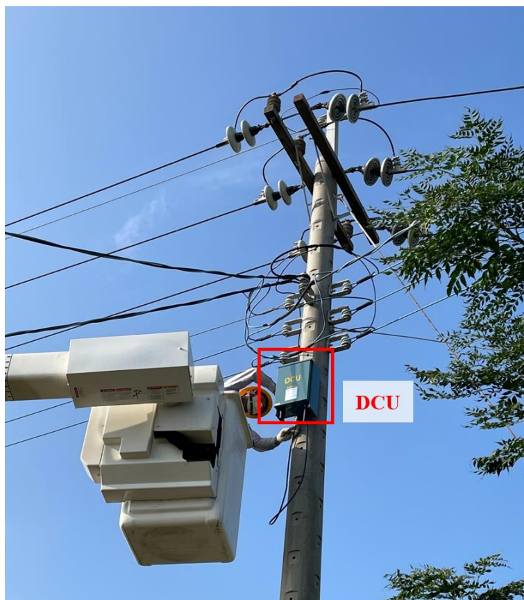
圖 68 DCU 安裝之高空作業(饋線 XD35)
