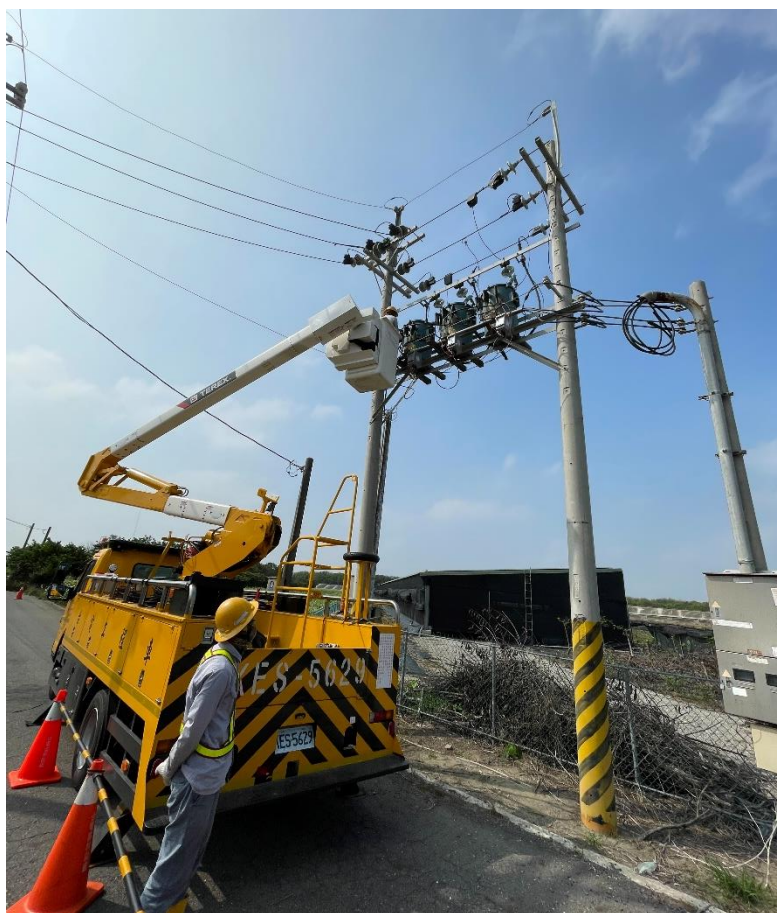
圖 70 TTU 安裝之高空作業(饋線 XH29)
