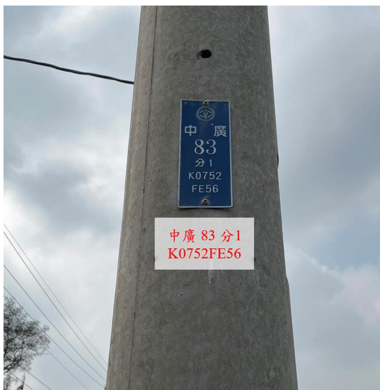
圖 69 TTU 之安裝桿號(饋線 XH29)
