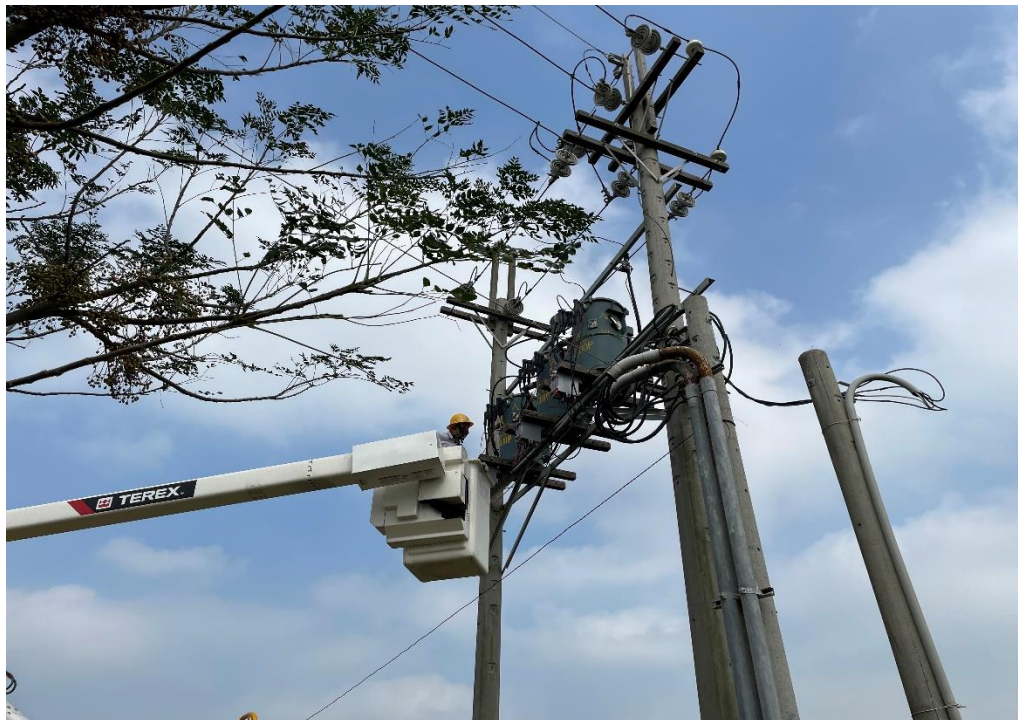
圖 65 TTU 安裝之高空作業(饋線 XD35)
