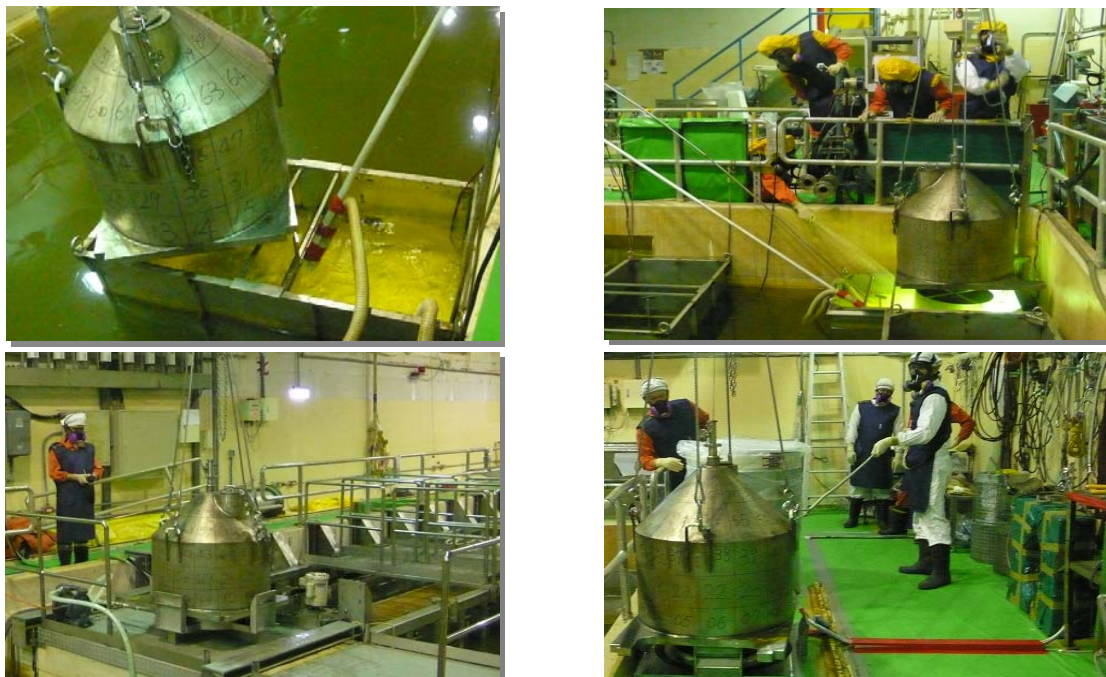
TRR 燃料池廢樹脂包裝移貯
