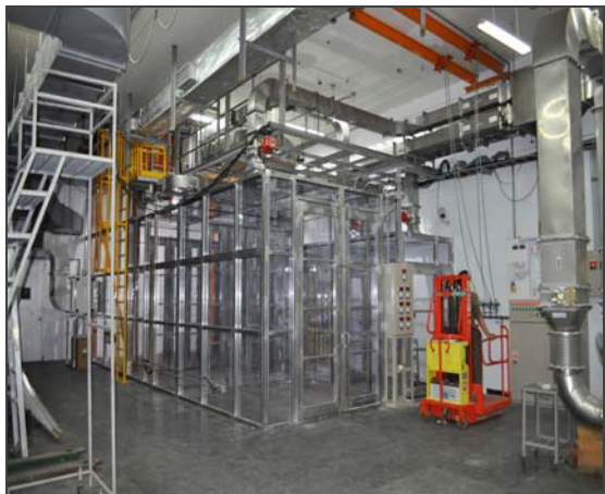
隔離帳篷(含負壓通風系統)建置
