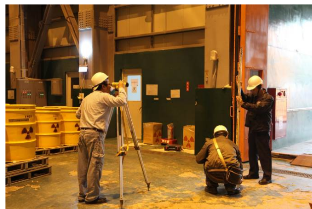
拆裝廠房建築結構體垂直水平變位測量作業
