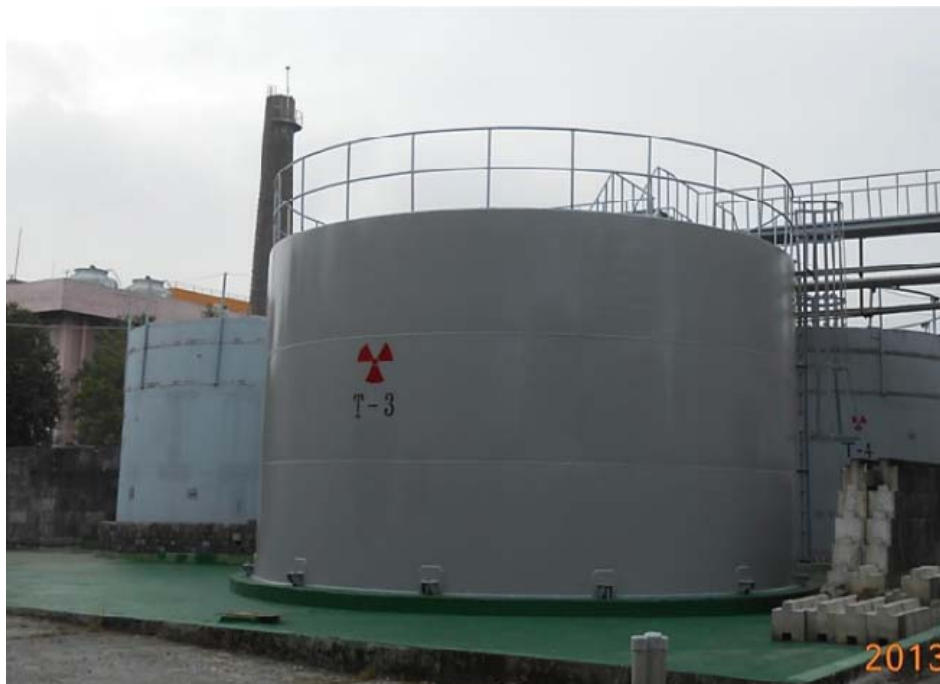
興建 015B 館前槽區廢液貯槽 1 只
