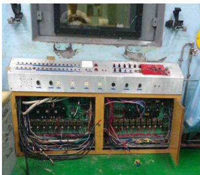
熱室 92 電力與控制系統線路與面板裝置更新前(左圖)與更新後(右圖)
