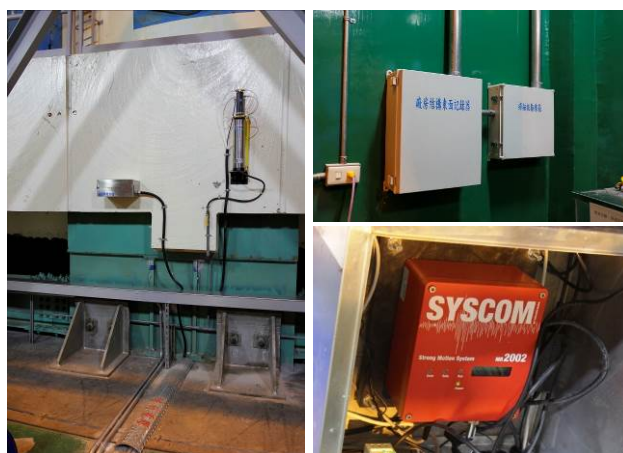
監測系統監測設備與管線建置
