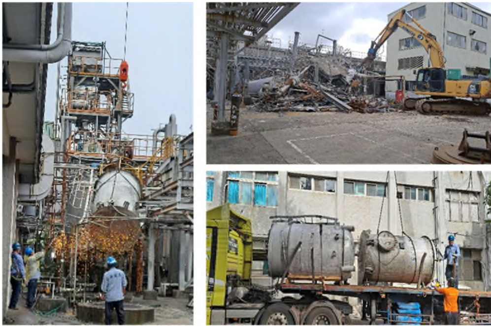
圖 12. 生質循環示範場域之舊有設備汰除
