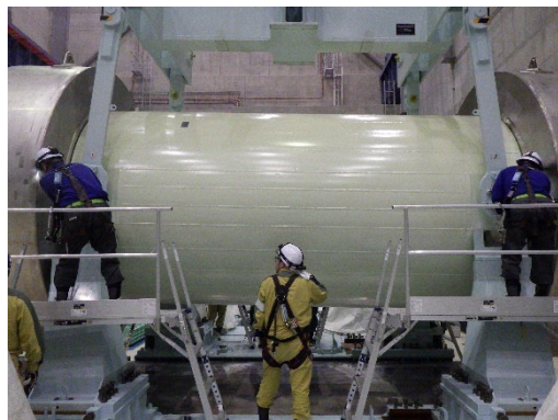
圖 32 (a)專門用於傳送用過核子燃料的多軸運輸車輛；(b)多軸運輸車輛於貯存庫檢查區內進行吊裝作業；(c)使用起重設備將護箱吊至垂直支架上；(d)垂直支架安裝作業[21]
