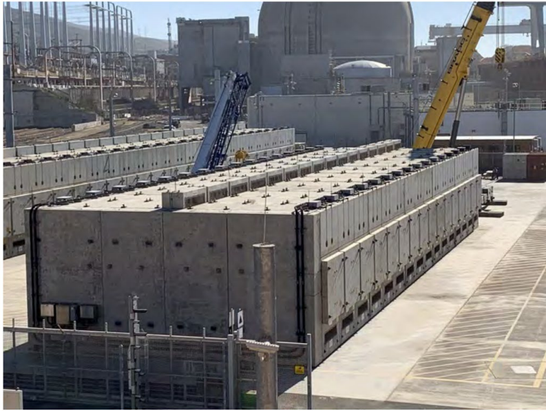
圖 16 TN 水平貯存系統(NUHOMS)安裝施工圖
