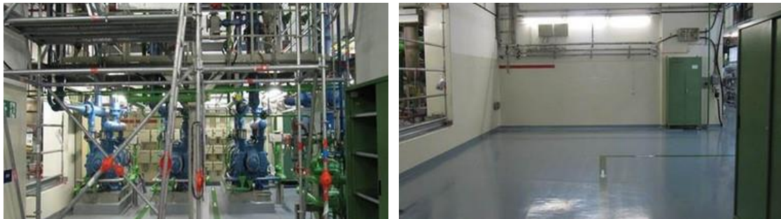
圖一、排氣系統 TS02 拆除前(左)與拆除後(右)。
