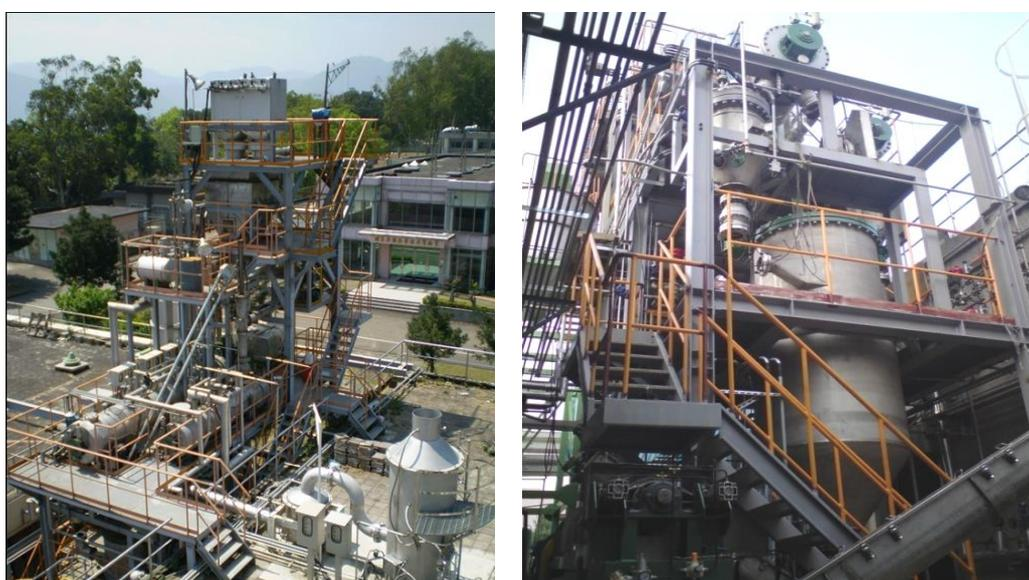
圖 4、測試廠之酸催化蒸汽爆裂前處理系統
