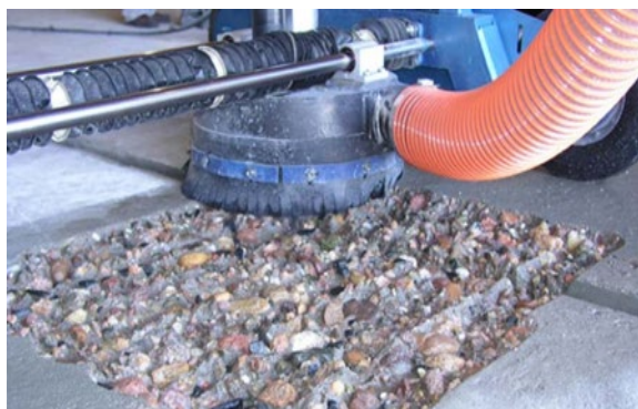
圖 1.2.41 利用遠程 hydrolasing 去除凝土表面[12] 圖 1.2.42 安裝在真空罩內的水磨噴嘴[12]
