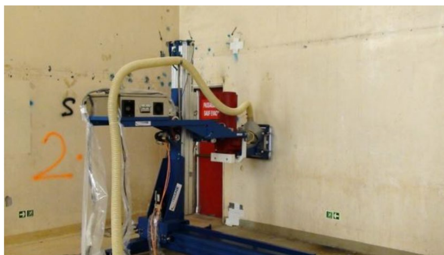
圖 1.2.31 起重機上的 Aspilaser[9]
