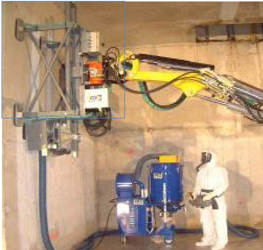
圖 1.2.19 使用重型機具來移動研磨頭的導向系統[9]
