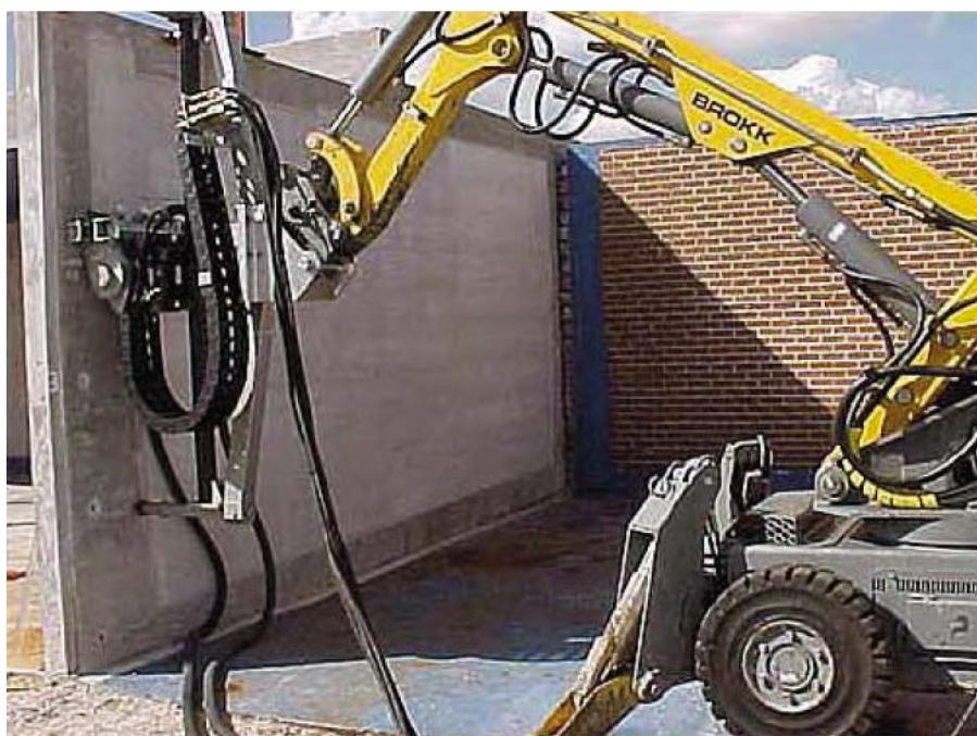
圖 1.2.14 安裝在 Brokk 250 上用於牆壁除污的刨除刀[22]
