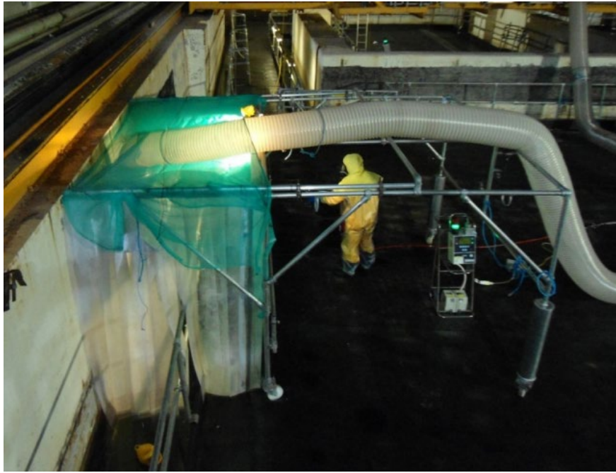
圖 1.2.43 Hunterston 高壓水噴射除污場景[11]
