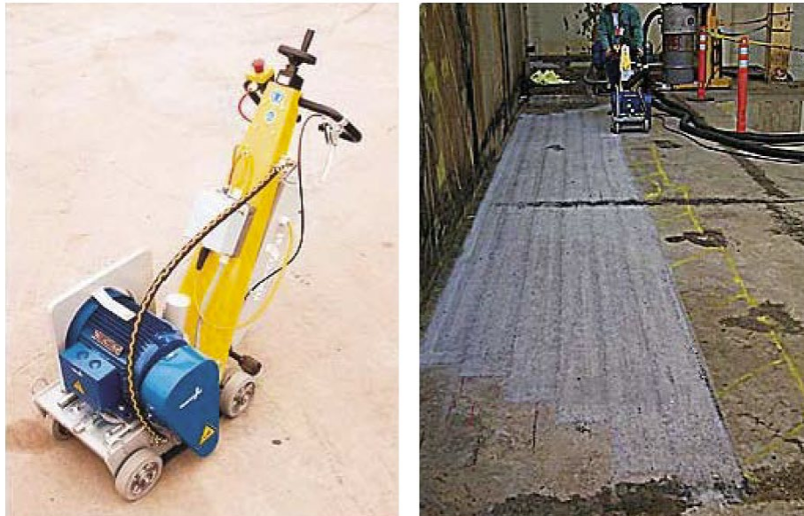
圖 1.2.13 Marcrist 地板刨除機及其生成的地板表面[22]
