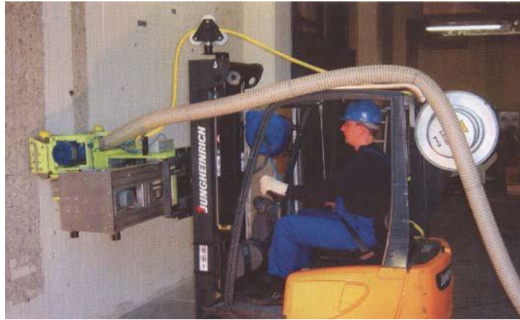
圖 1.2.16 連接在堆高機上的雙頭研磨機[9]
