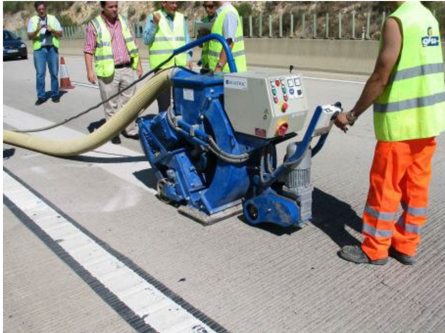
圖 1.2.25 商用地板噴砂系統[9]
