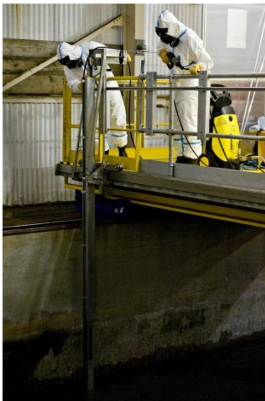
圖 1.2.39 以高壓水噴射進行曾淹沒在水位以下的水池除污[11]
