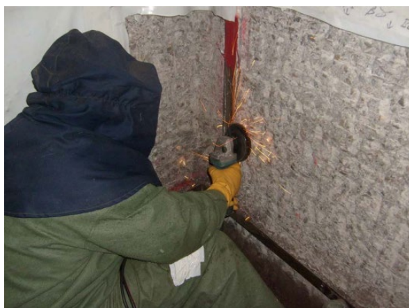
圖 1.2.40 池中混凝土除污[11]
