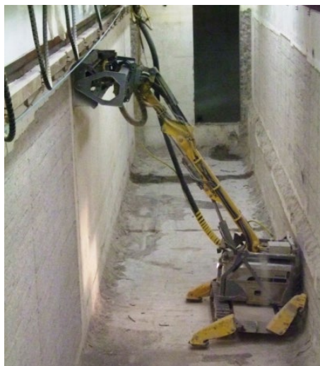
圖 1.2.44 Trawsfynydd 水池渠道的乾式粗琢[11]
