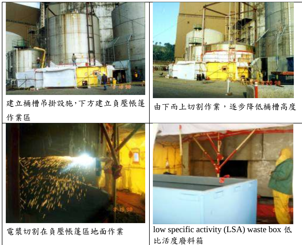
圖 2-2.13 一次側爐水儲存槽拆除作業(Trojan)
