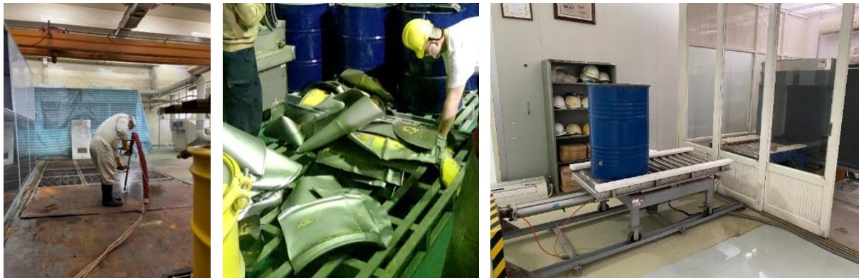
圖 2-30、主庫廢金屬高壓水噴洗、機械除污、偵檢量測作業
