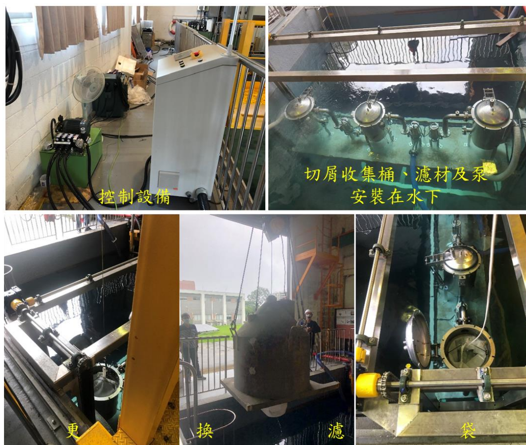
圖 2-2、水下放射性金屬切屑收集及水質淨化設備
