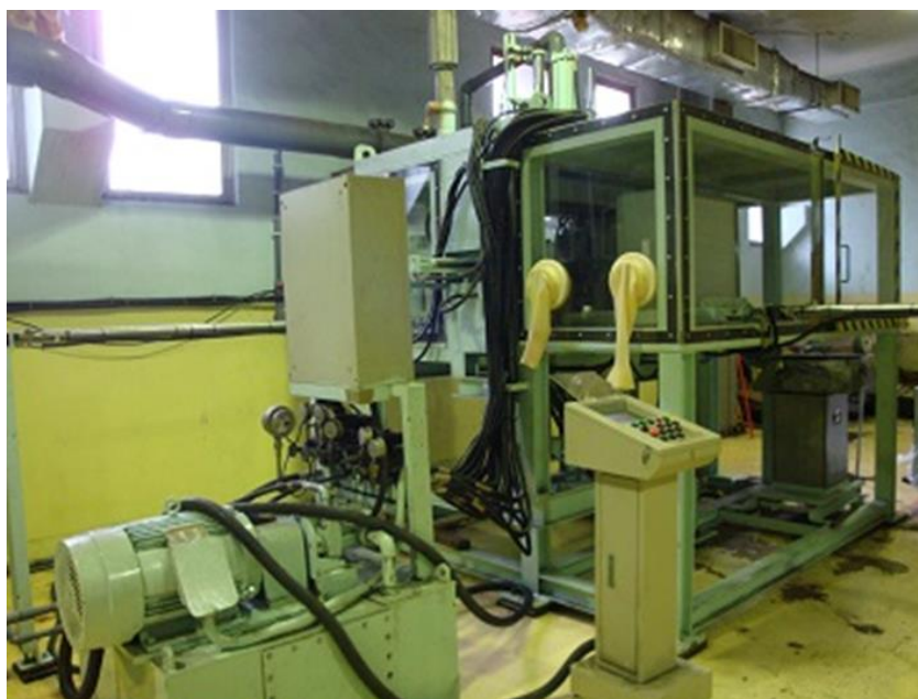
圖 2-23、絕對過濾器壓縮處理
