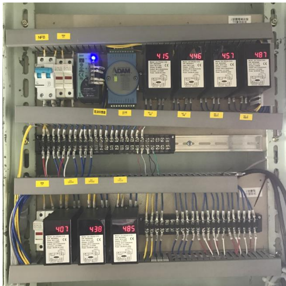
圖 26 冷卻系統量測設備(左)與基線模型介面(右)
