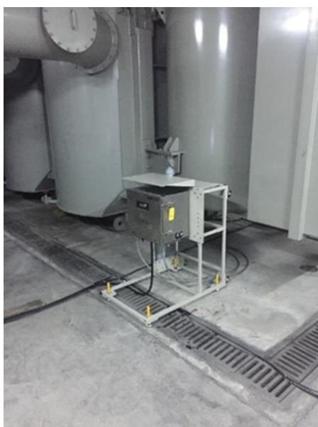
圖 40 即時量測變壓器絕緣油中氣體分量
