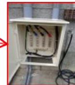
功率調節系統併接盤
