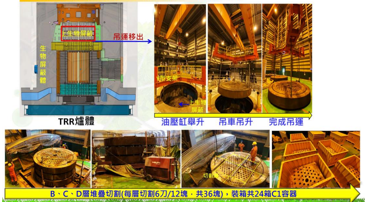
圖 2-3、上生物屏蔽 B、C、D 層吊運、切割及裝箱
