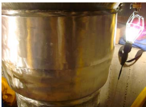
調壓槽模型 4 吋 Surge nozzle 覆銲並研磨後成果
