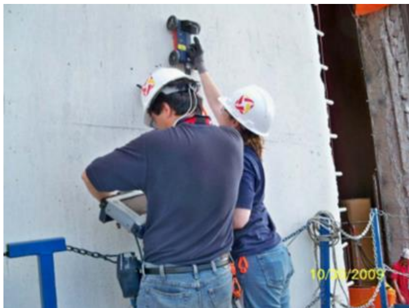
圖 4.22 水晶河 3 號核電廠現場透地雷達檢測
