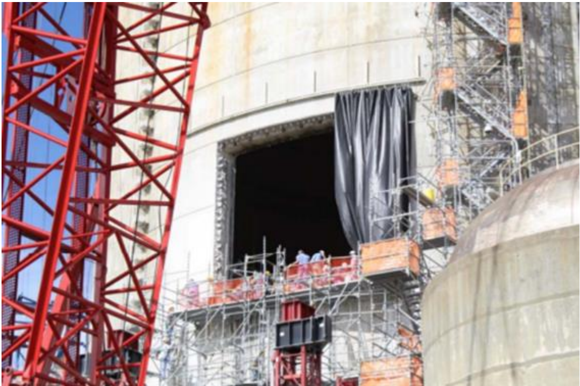
圖 2.5 在原進出口上方圍阻體牆體和襯裡切一面積 25×27 英尺開口
