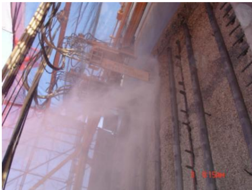
圖 2.6 圍阻體牆體上混凝土清除作業
