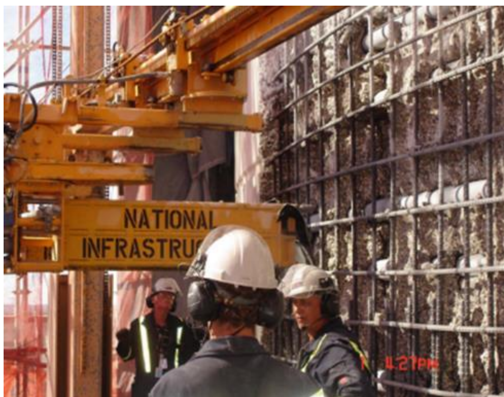
圖 2.7 圍阻體牆體混凝土開口作業
