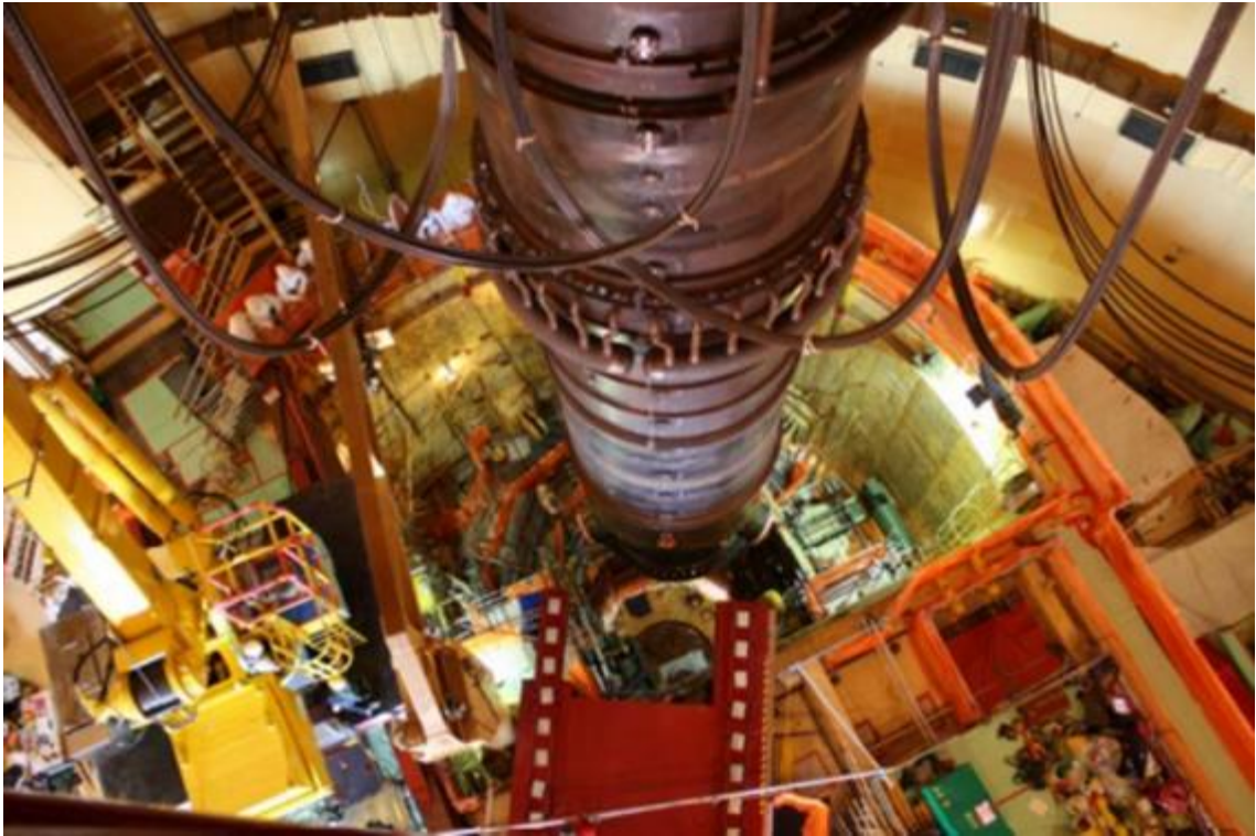
圖 2.4 原設計的 SG 換裝作業
