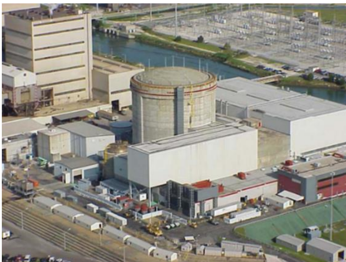
圖 1.1 水晶河 3 號核電廠之壓水式反應器及廠房
