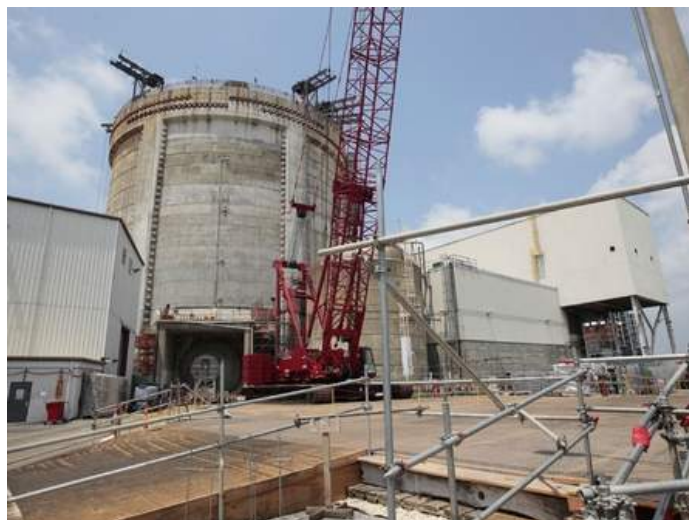
圖 2: Crystal River 3 號機圍阻體施工搭架外觀
