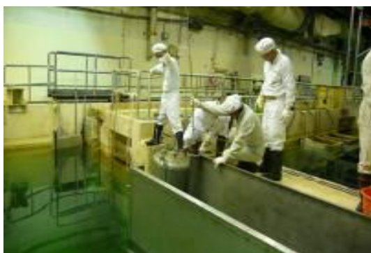
廢樹脂罐頂閥件拆除作業
