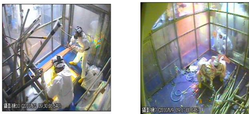
圖二、A55 室管線切割作業
