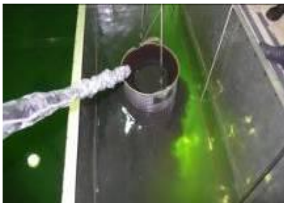
廢樹脂罐內取出作業
