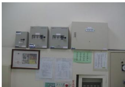
圖二、015D 地下庫避雷系統改善及突波吸收器安裝
