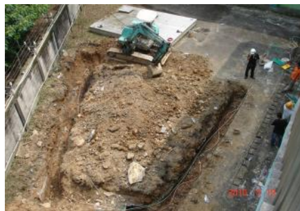
圖二、015D 地下庫避雷系統改善及突波吸收器安裝
