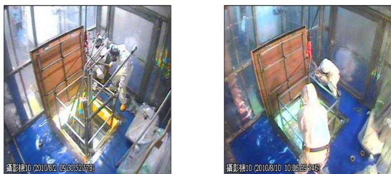
圖三、A43 室 TRU 廢棄物吊掛作業
