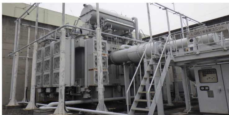
圖 3-26 女川 1 號機-主變壓器的拆除例子
