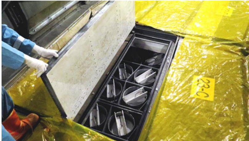
圖 3- 37 大飯 1、2 號機-冰冷凝器型式圍阻體
