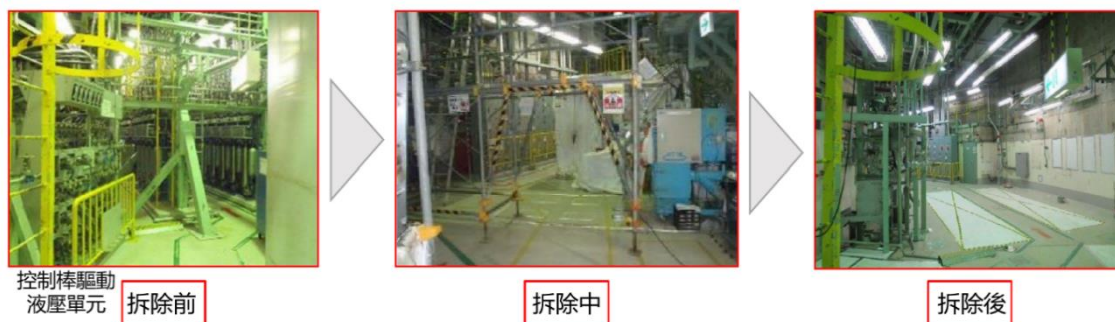
圖 3-14 敦賀 1 號機-反應器廠房一樓南側區域控制棒驅動單元等拆除作業
