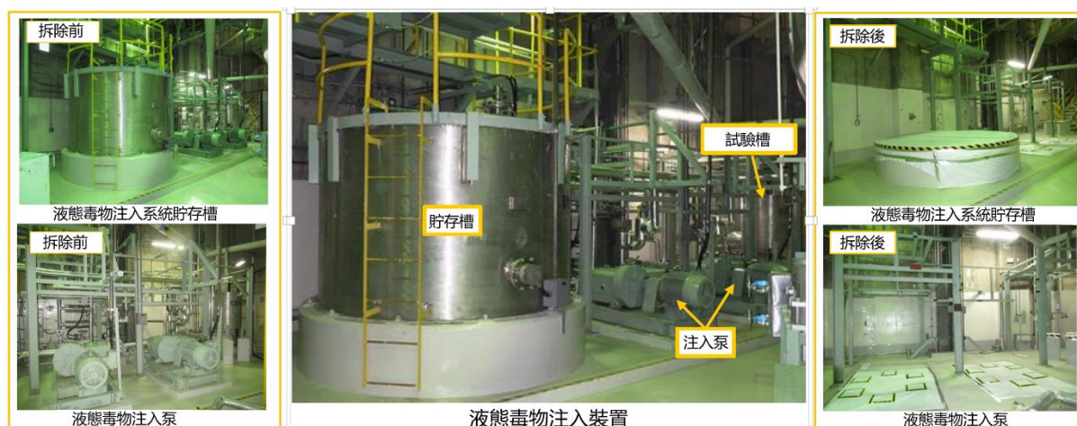
圖 3-22 敦賀 1 號機-液態毒物注入系統拆除作業
