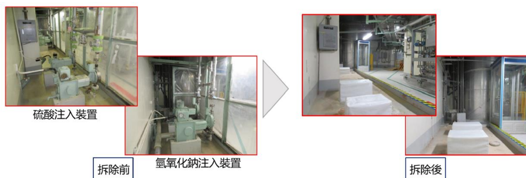
圖 3-21 敦賀 1 號機-藥劑注入泵等拆除作業
