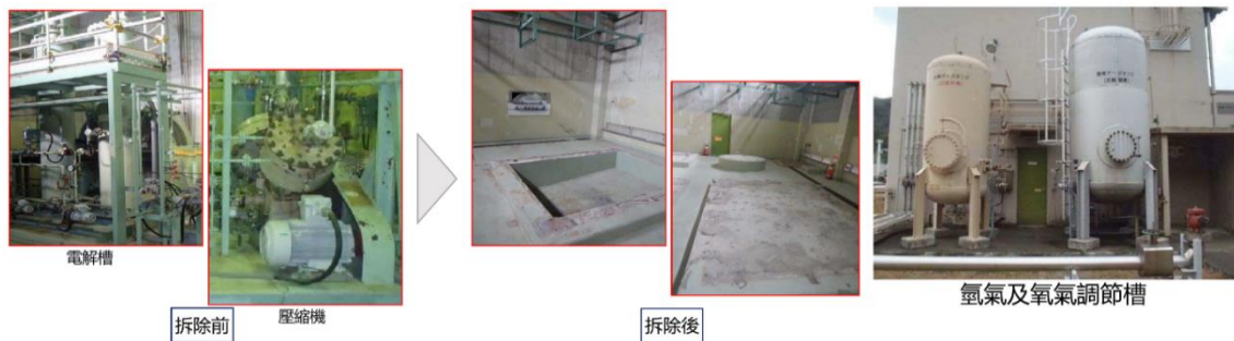
圖 3-16 敦賀 1 號機-氫氣及氧氣產生器(水電解裝置)拆除作業
