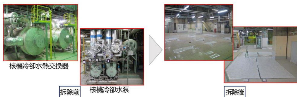
圖 3-17 敦賀 1 號機-汽機核機冷卻系統熱交換器等拆除作業
