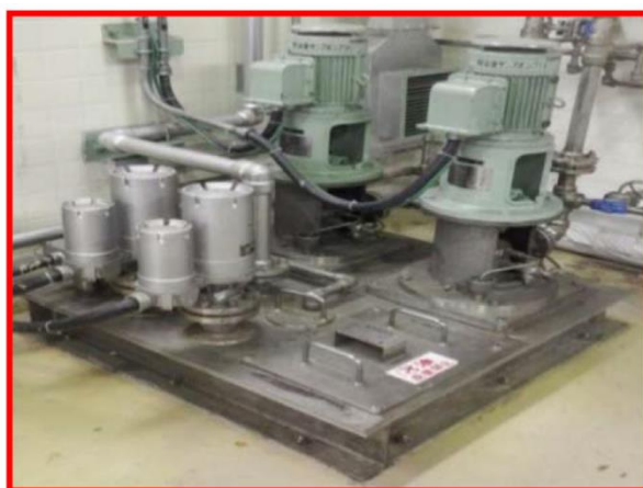
排水坑除污作業 (汽機廠房一樓、2017/5/15~6/9)
