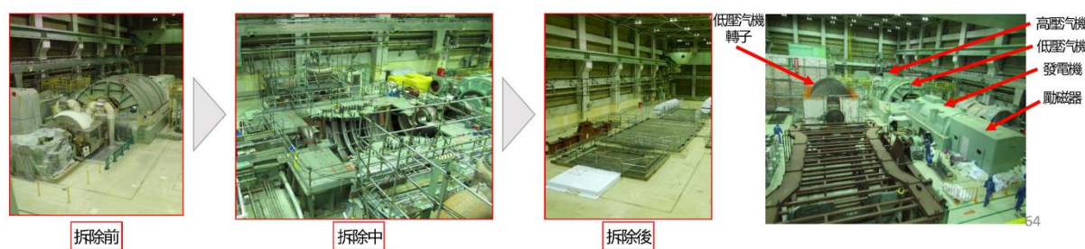
圖 3-15 敦賀 1 號機-汽機廠房三樓汽機、發電機等拆除作業
