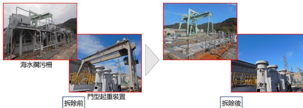
圖 3-20 敦賀 1 號機-進水口區域拆除作業
