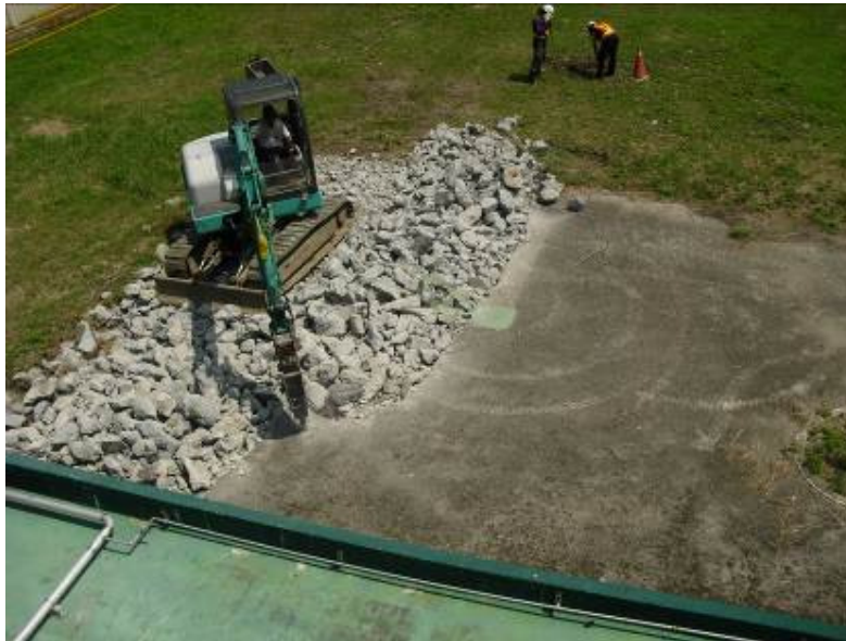
貯槽移除安座基礎開挖作業
