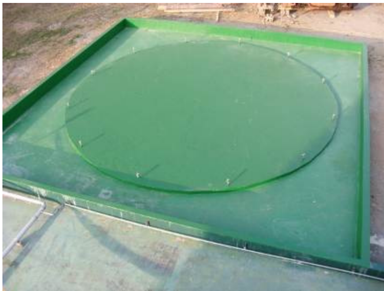
完成貯槽移除安座基礎一座
