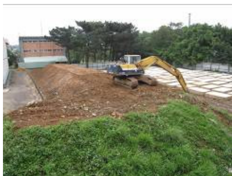
延遲槽建窖混凝土塊移出進行量測分析
