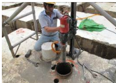
混凝土塊污染管線鑽除
