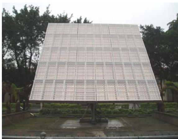
圖 38：7.5 kW HCP v 系統
