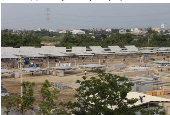
圖 24：系統安裝工程
