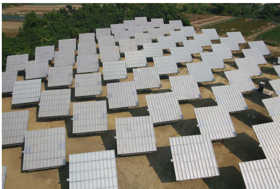
圖 25：MW級市電併聯型太陽光發電示範系統
