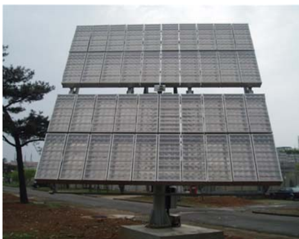
圖 37：5 kW HCPV 系統
