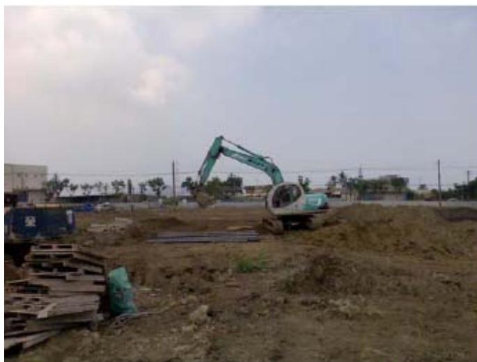
圖 23：整地工程及管線埋設
