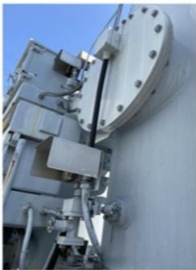
(a) 斷路器局部放電量測
