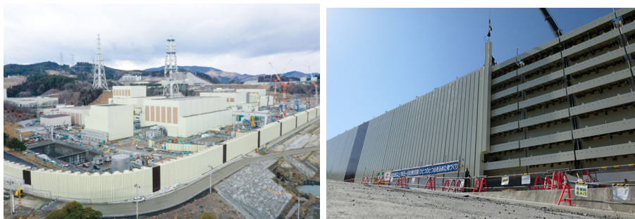
圖 4-48 核電廠周圍防洪設施(Tohoku Electric Power Co., 2019)
