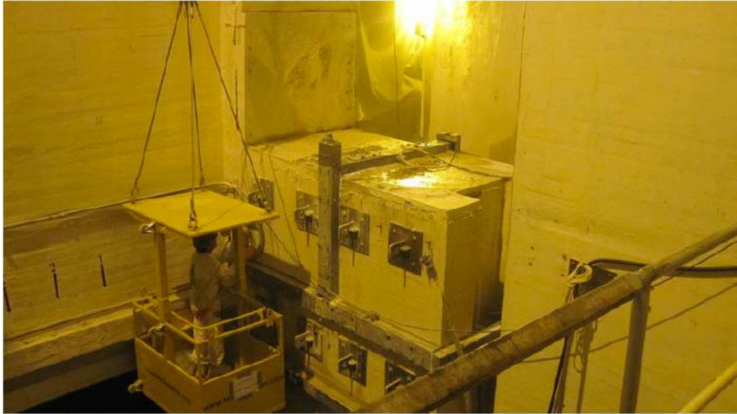
圖 1-24 拆除反應器爐穴與水池之間的牆壁
