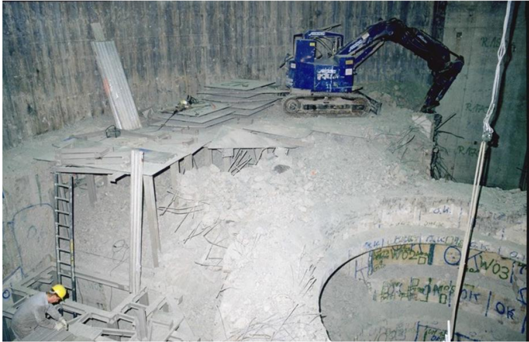
圖 1-13 德國 Karlstein 過熱蒸汽反應器使用遠端挖土機拆除反應器水池
