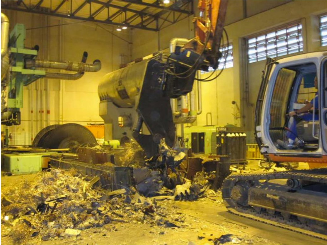
圖 1-19 拆除汽機組件
