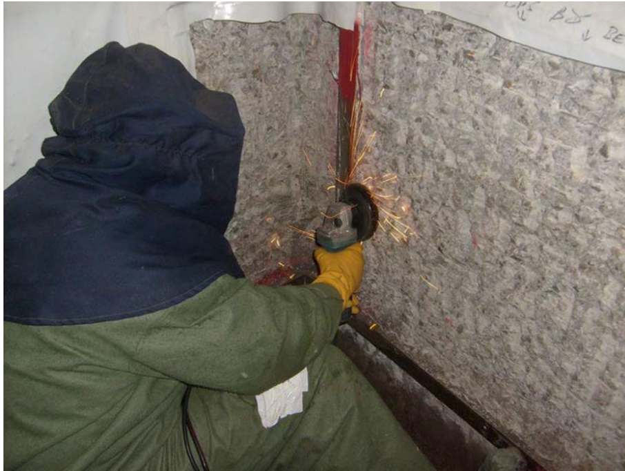
圖 1-12 英國 Dounreay 場址(快中子反應器)水池混凝土除污
