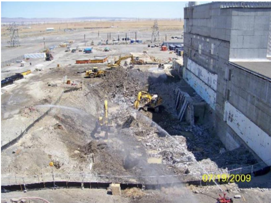
圖 1-14 美國 Hanford 224-U 設施拆除過程中用水作為抑塵劑
