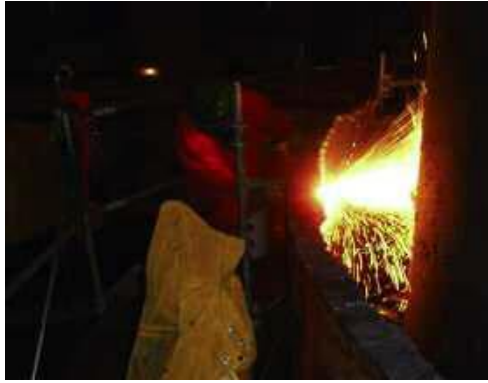
圖 2-34 第一機組蒸汽產生器的上半部在原位進行分段切割
