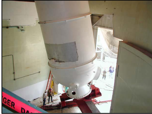
圖 2- 31 蒸汽產生器一號進行下傾放置作業
