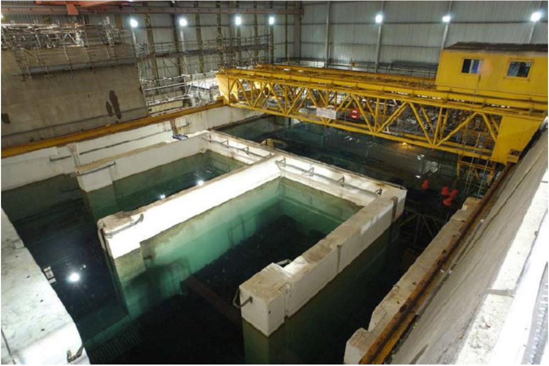
圖 1-7 英國 Hunterston 盒式冷卻池 (Cartridge Cooling Pond)
