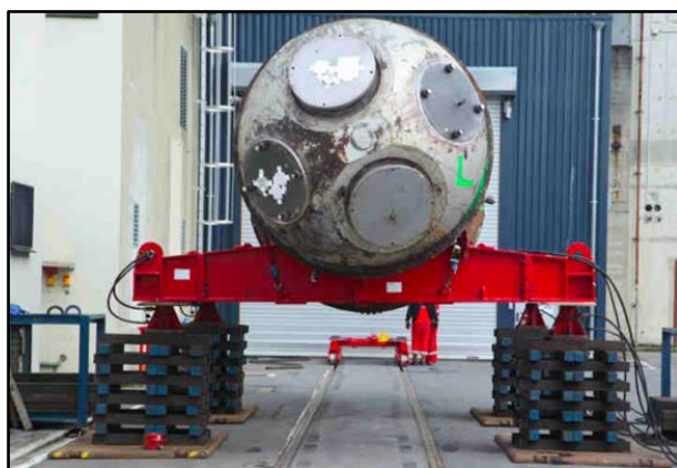
圖 2- 24 蒸汽發生器由千斤頂系統抬升
