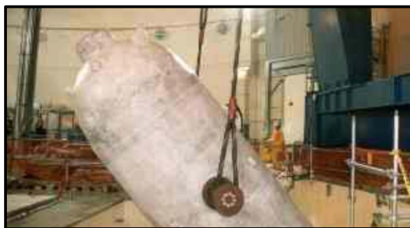
圖 2- 59 調壓槽的移動過程
