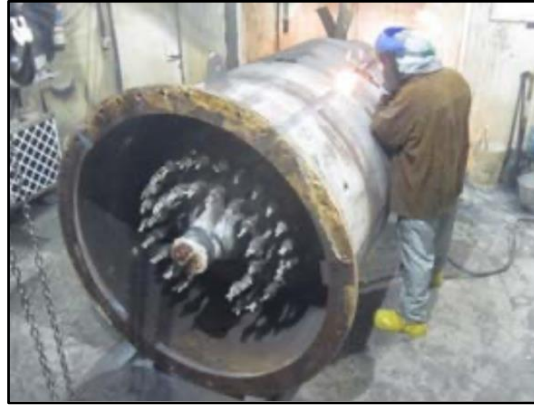
圖 2- 11 調壓槽切割過程
