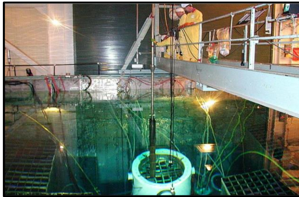
圖 2- 54 將燃料移入 MPC 過程示意圖
