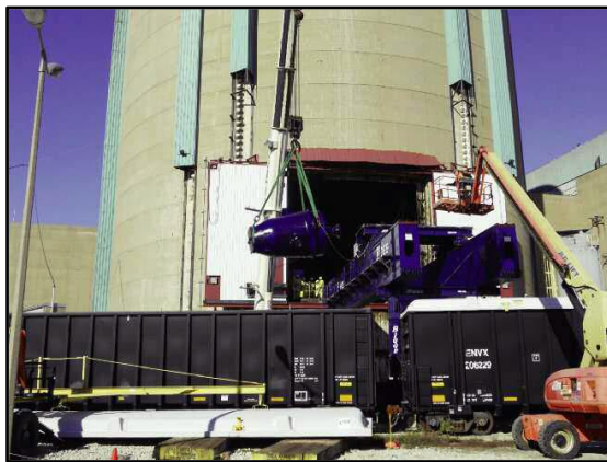
圖 2- 36 反應器冷卻泵吊掛固定於鐵路貨車上，準備運送至 LLW 處置
