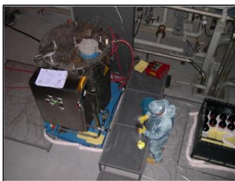
圖 2-8 全系統化學除污過程
