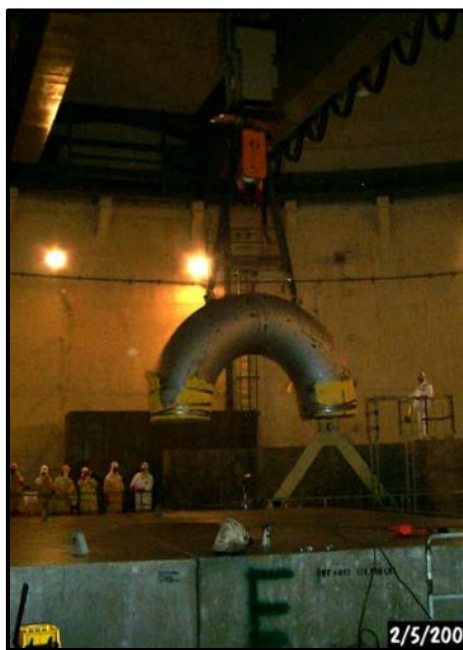
圖 2- 52 主冷卻管線第一段組件移除作業
