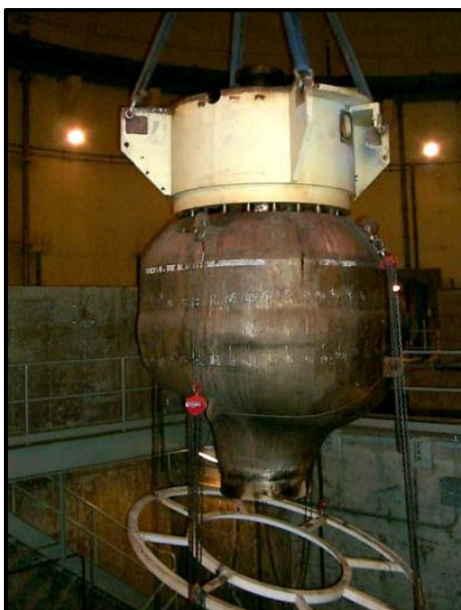
圖 2- 50 反應器冷卻泵移除作業
