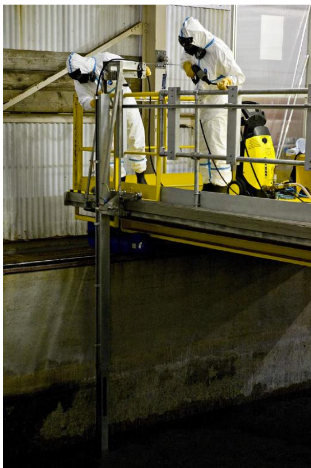
圖 1-11 英國 Dounreay 場址(快中子反應器)用高壓水槍清洗水面下的水池
