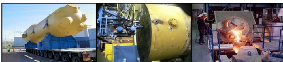
圖 2-16 蒸氣產生器的運輸、管束抽取與熔融作業現場照片
