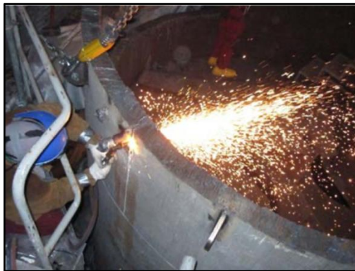
圖 2- 12 蒸汽產生器切割過程
