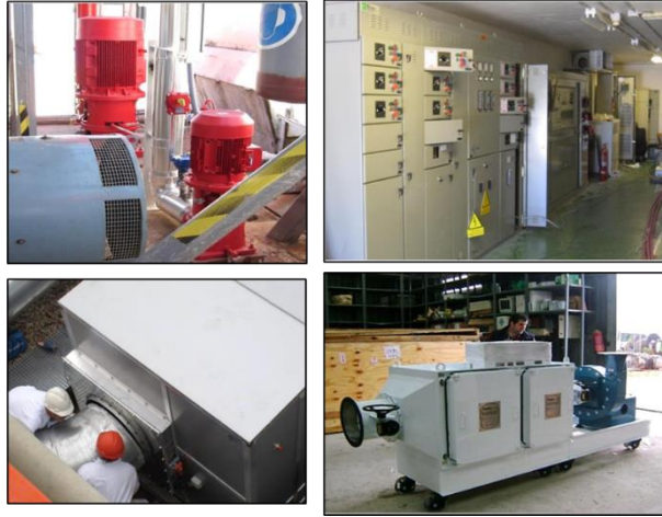
圖 2-9 輔助設施改造：防火、電力、通風與過濾系統改造
