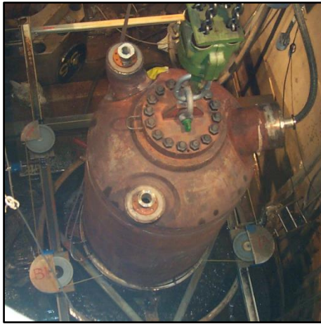
圖 2- 20 在 BR3 蒸汽發生器上使用鑽石鋼索進行切割
