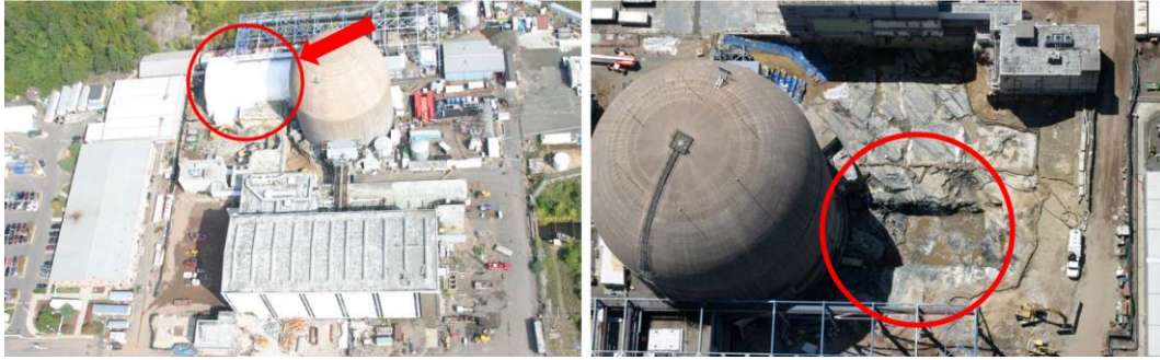
圖 2-55 土壤污染補救措施進行過程
