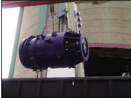
圖 2- 35 Unit 1 反應器冷卻泵吊升至鐵路貨車中
