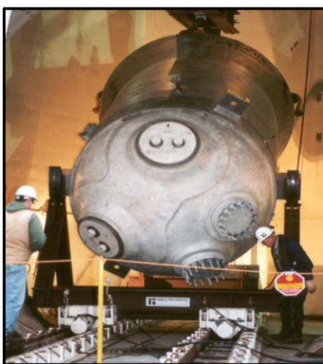
圖 2- 58 蒸汽產生器下半部移出過程
