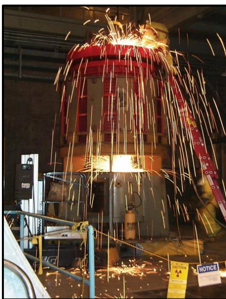
圖 2- 51 反應器冷卻泵馬達的切割作業
