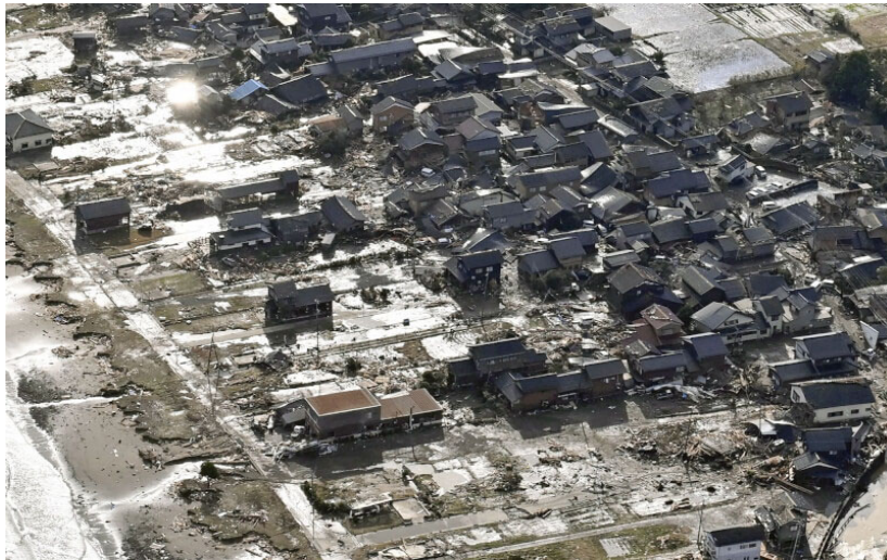
圖 3-35 珠洲市房屋倒塌（周中哲等人，2024）
