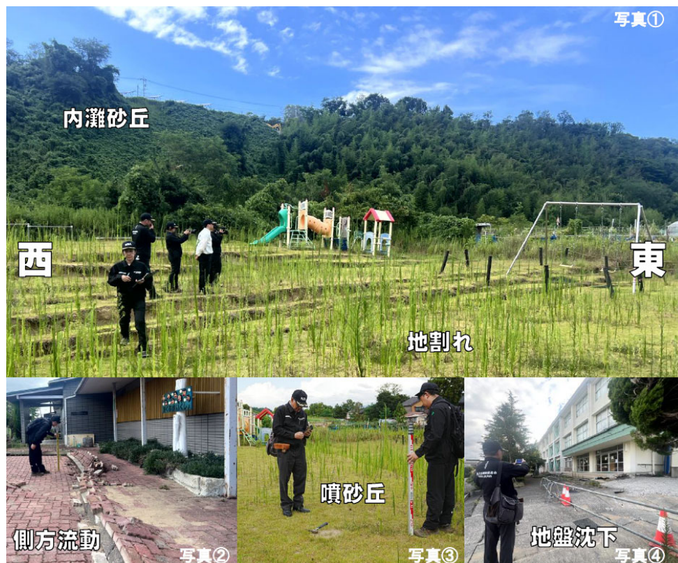
圖 3-61 液化造成地表裂縫、沙湧與沉陷
