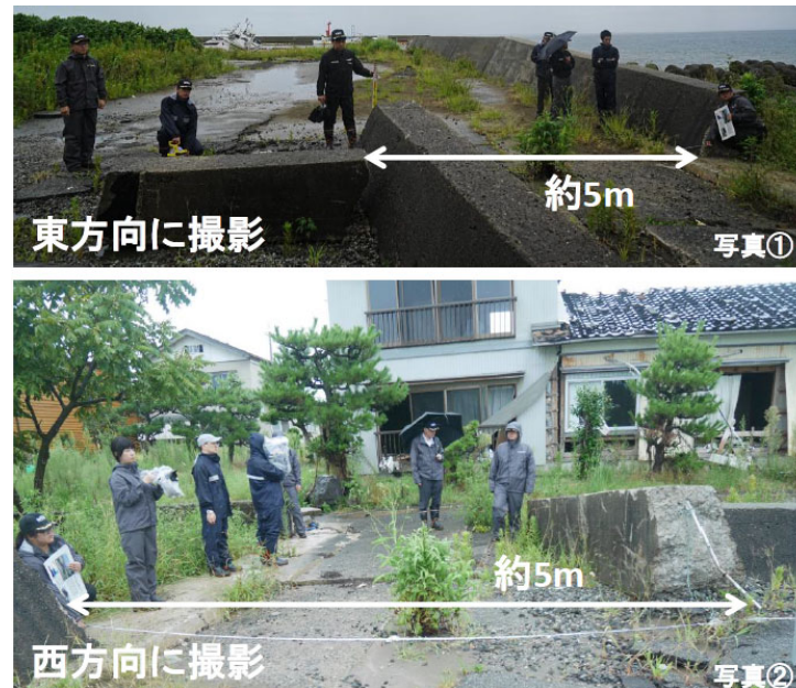
圖 3-58 鵜鵜漁港受海嘯海堤破壞
