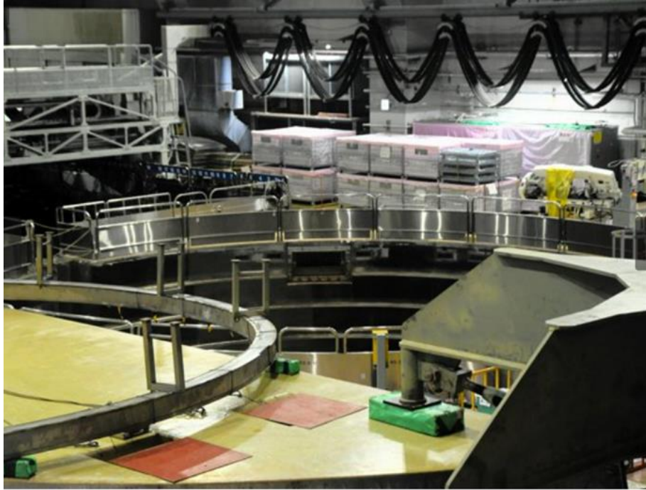
圖 3-36 濱岡 2 號機反應器廠房內的抑壓池（已規劃為低放射性廢棄物暫存區） 10
