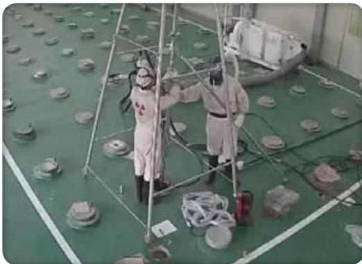
圖3、DSP貯存孔除污測試
