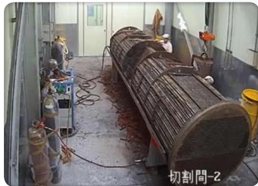
圖4、TRR主冷卻水熱交換器切割作業
