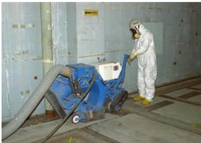
圖 5-2 混凝土地板除污[16]
