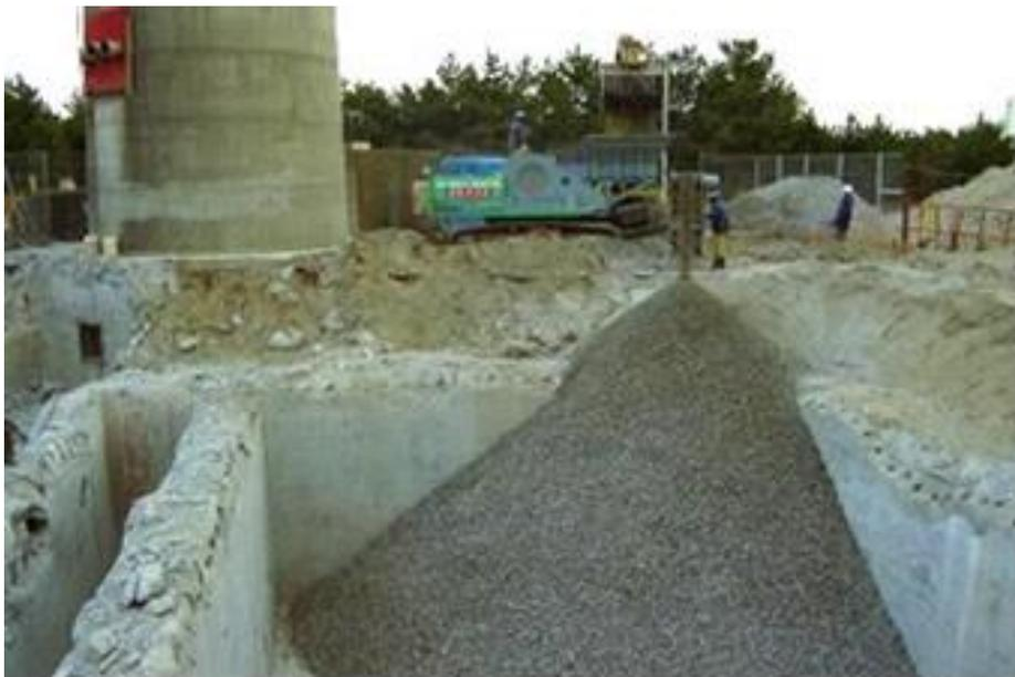
圖 5-12 經粉碎處理後之非放射性混凝土窪地回填作業[16]
