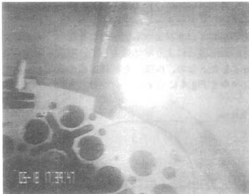
圖 4-8 利用電漿弧遠端切割工法拆除壓力槽內部結構物[6]
