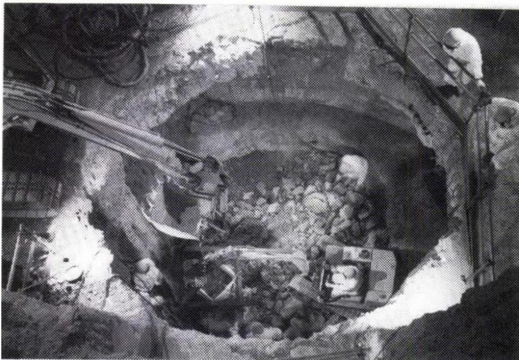
圖 4-23 控制爆破施工後的破碎混凝土塊收集作業[8]
