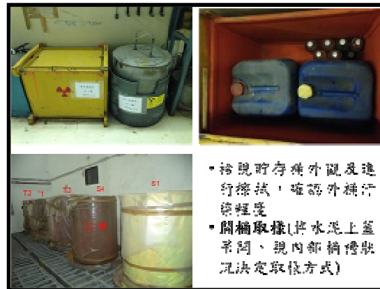
放射性乙二醇之貯存情形及取樣作業
