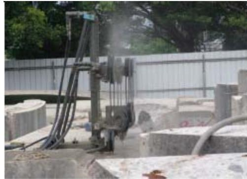
圖二、鑽石索鋸混凝土塊切割(傳統式)
