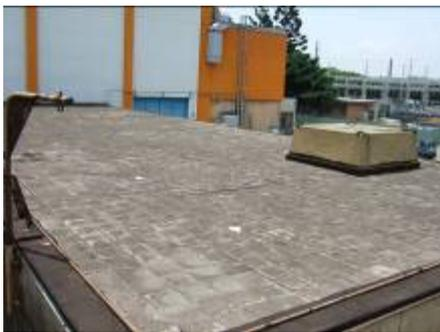
圖五、燃料池屋頂防漏改善工程(改善前)
