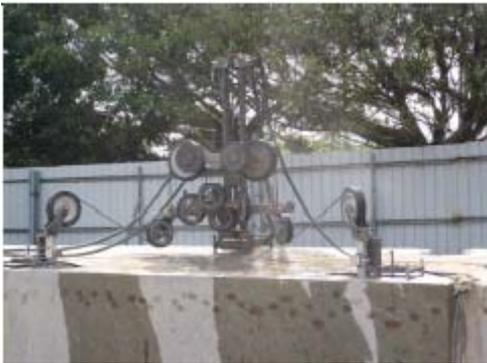
圖一、鑽石索鋸混凝土塊切割(插入式)
