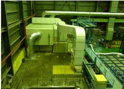
圖三、於大廳半樓設置燃料池風管、外氣空調箱、排風機及濾層裝置
