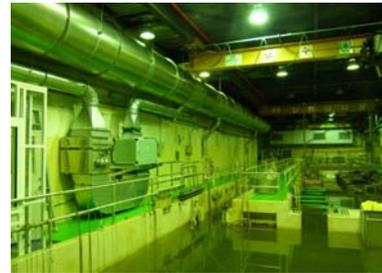
圖四、燃料池廠房之風管、隔離間濾層裝置及 2hp 排風機
