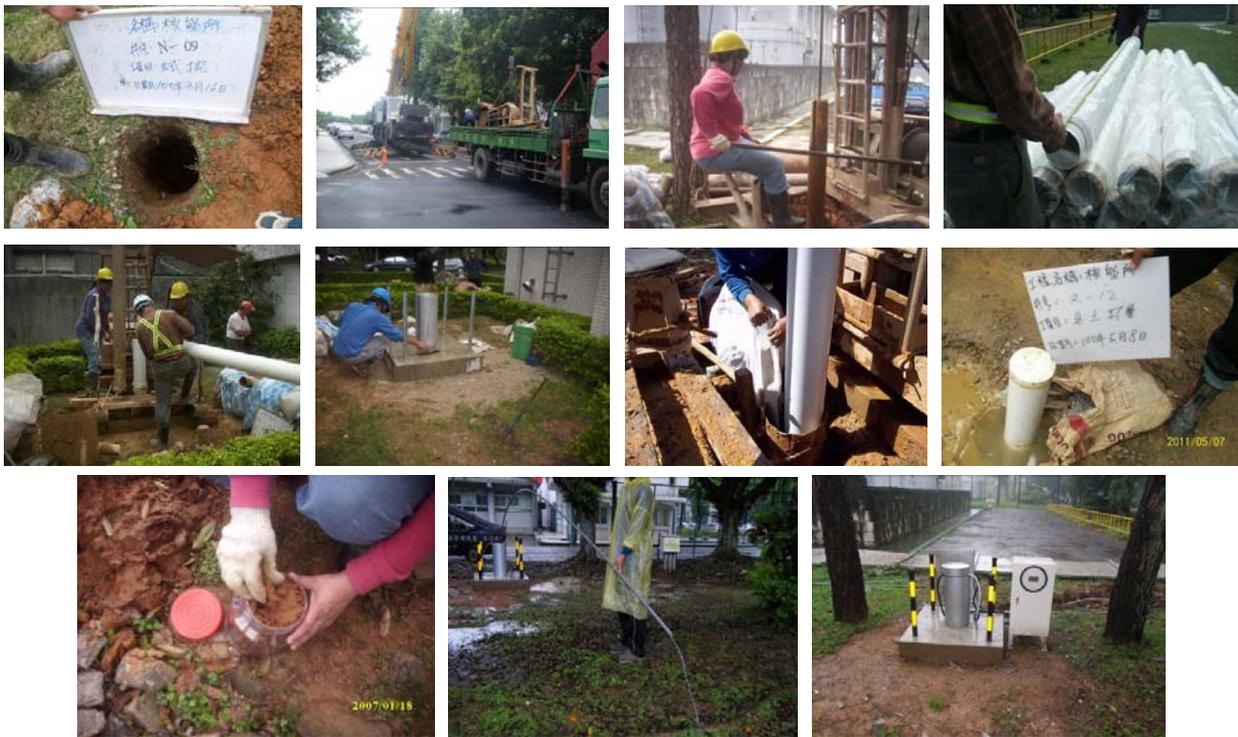
圖一、取樣孔鑽鑿作業
