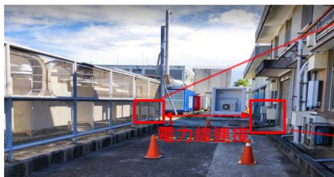
三相功率調節系統與柴油機併聯盤配置
