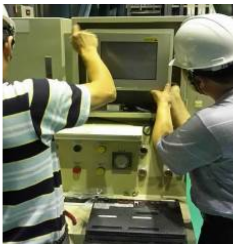
機械除污現場組裝測試
