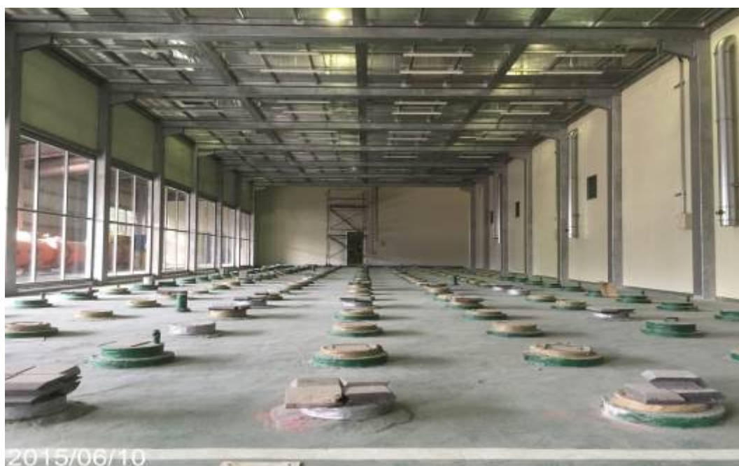
DSP 貯存孔區隔離帳篷設置前後狀況
