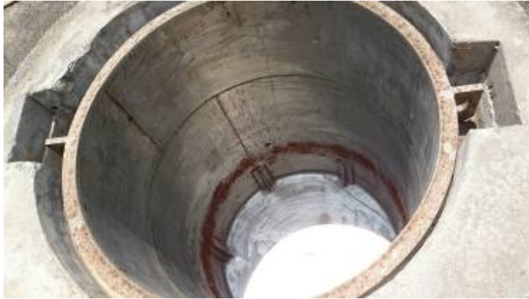
4 號窖廢樹脂清空後照片
