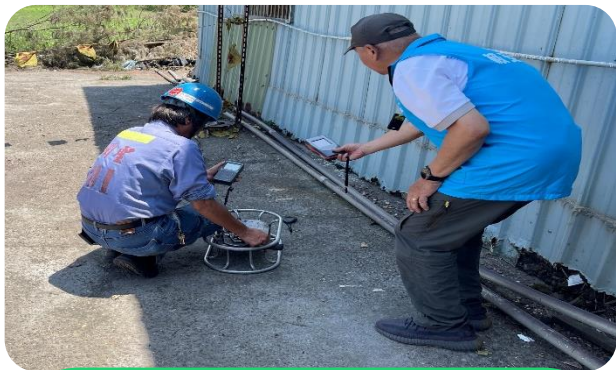
放射線照相檢驗業 工地輻安稽查
