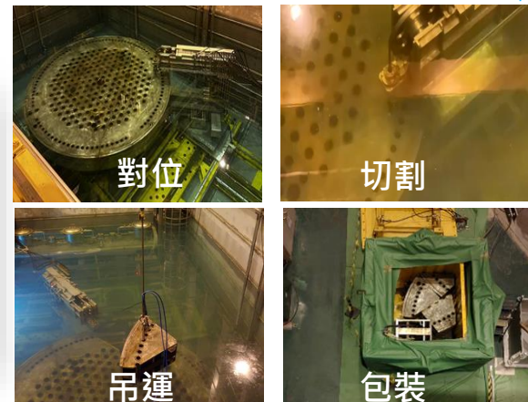
上熱屏蔽水下切割作業
