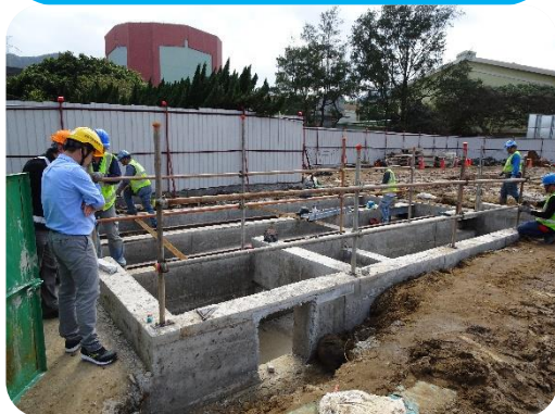
核二廠室外乾貯設施 動工興建
