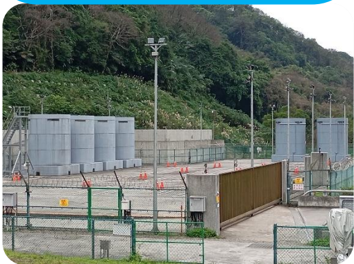
核一廠室外乾貯設施 完成熱測試
