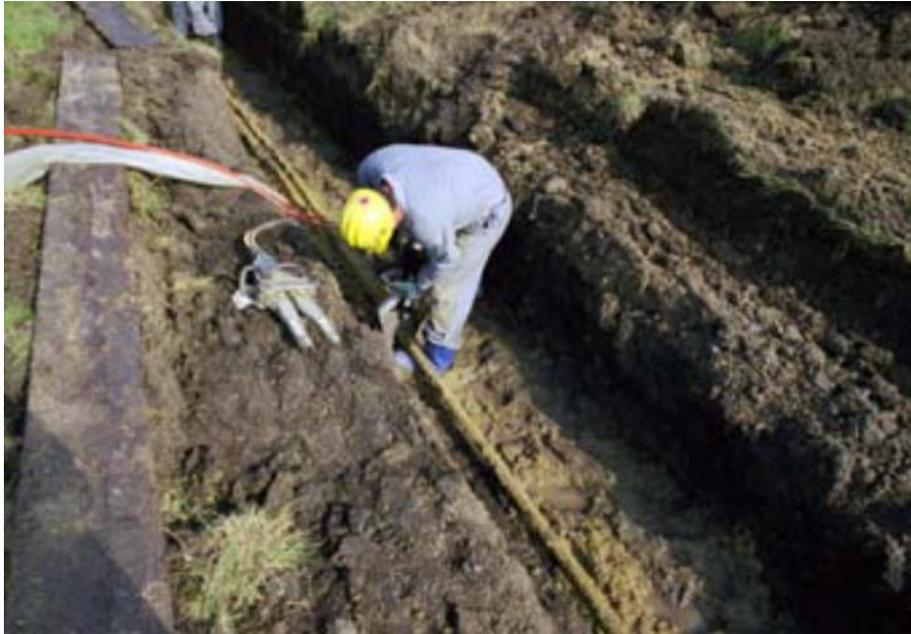
圖 2-13 在美國伊利諾州阿貢的 ANL 氣動傳輸管工程中，使用液壓切割機拆除埋入式管路
