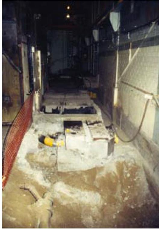
圖 2-4 拆除熱室：在加拿大渥太華 Tunney's Pasture 放射性同位素生產設施中，拆除各種嵌入式處理系統，以便進行維護
