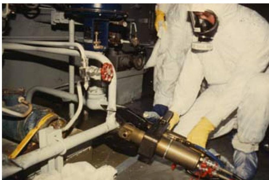
圖 2-12 比利時 Mol 除役計畫，使用液壓剪切割直徑達 2 英吋(5 cm)的管
