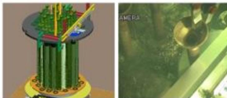
圖 3-55 在上部內部部件上切割護罩管
