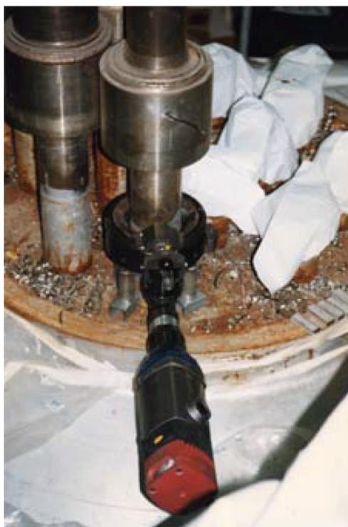
圖 2- 11 比利時 BR-3 Mol 除役計畫，使用車床軌道切割機，切割反應器
