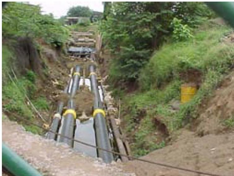
圖 2- 16 印度 Cirus 反應器的地下主冷卻劑管路在回填前，應用新的冷自黏瀝青膠帶(cold self-adhesive bituminous tapes)情況
