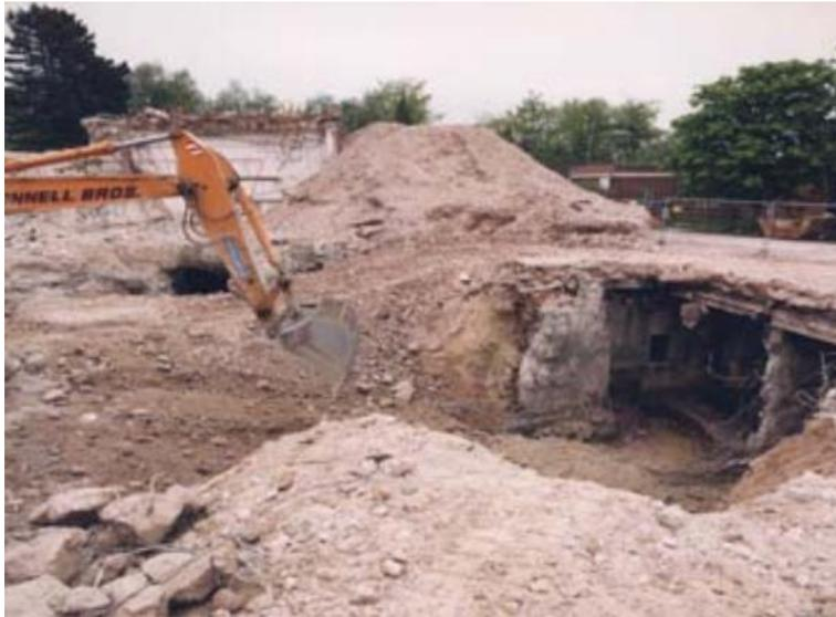
圖 2- 30 BEPO 拆除管道出口
