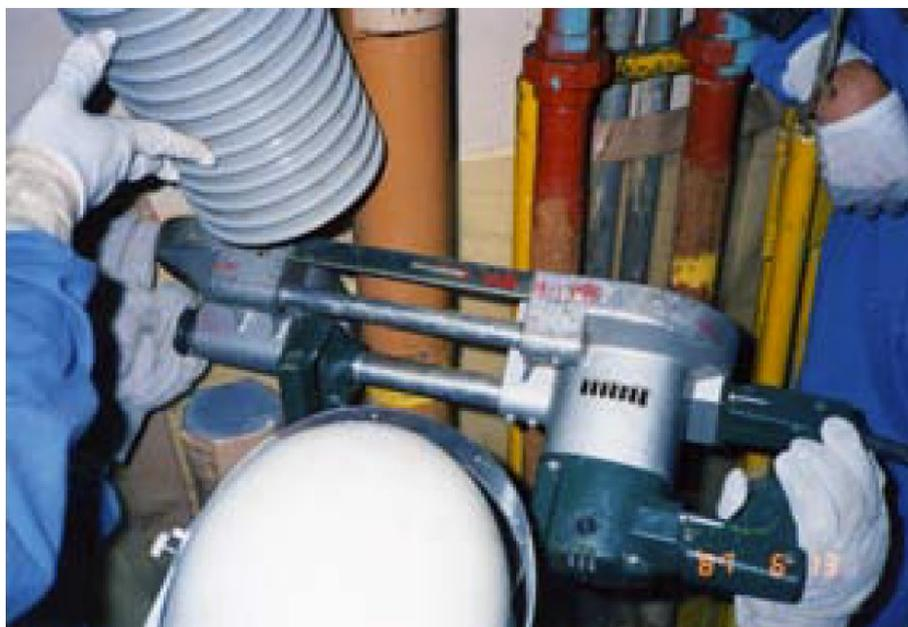
圖 2- 10 日本 JPDR(日本發電示範反應器)除役計畫，使用帶鋸切割管路
