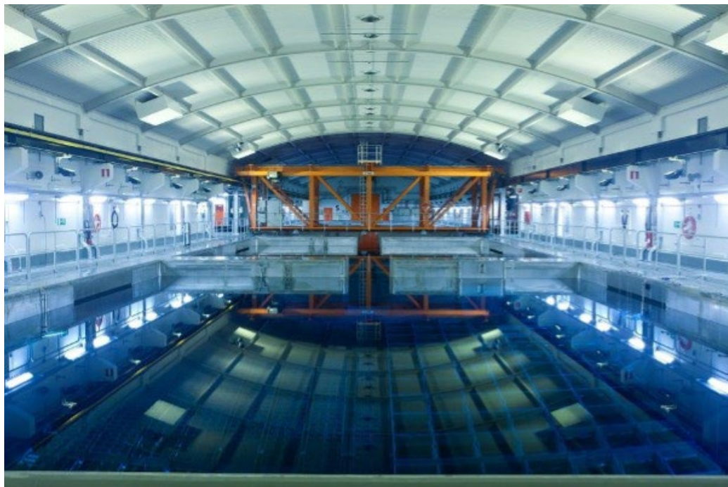
Oskarshamn 用過核子燃料 Clab 集中式中期貯存設施
