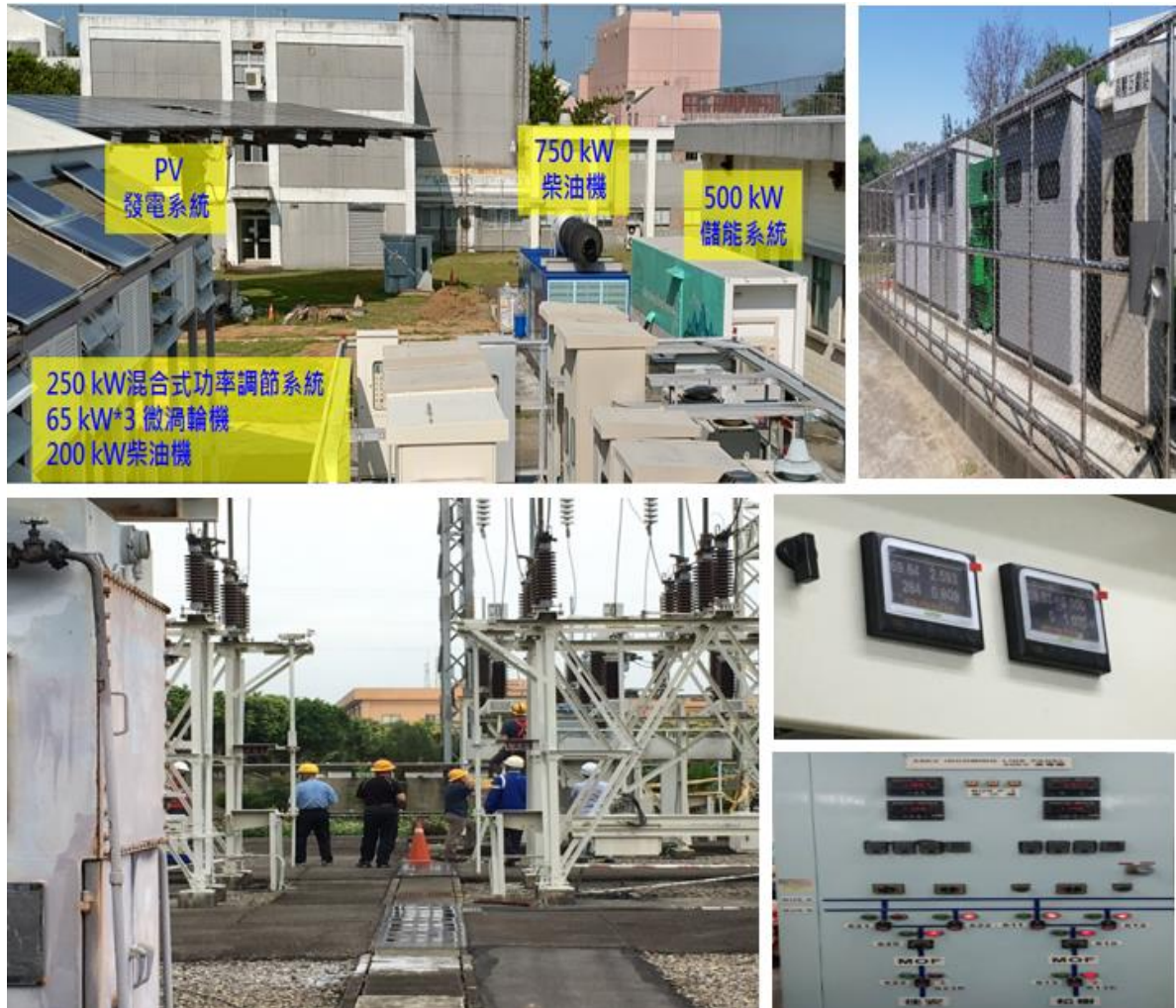
圖 46、MW 級微電網發電設施、核研所 69kV 系統之快速電錶裝設
