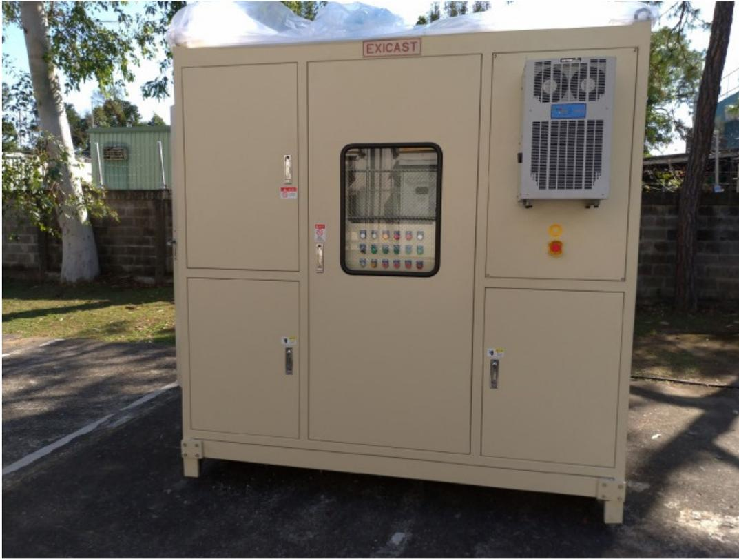
圖 3：5kW / 10kWh 鈔電池儲能系統(對照第 9 頁說明)
