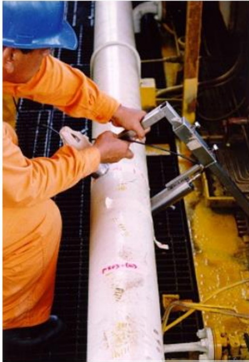
圖 2-6 管道腐蝕檢測
