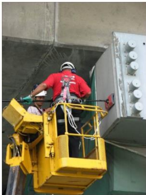
圖 2-7 混凝土中的水分檢測
