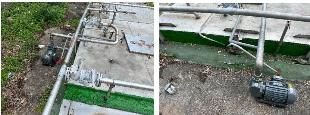
圖 2-18 完成 015A 館除污間室外水槽修補及輸送抽水泵更換
