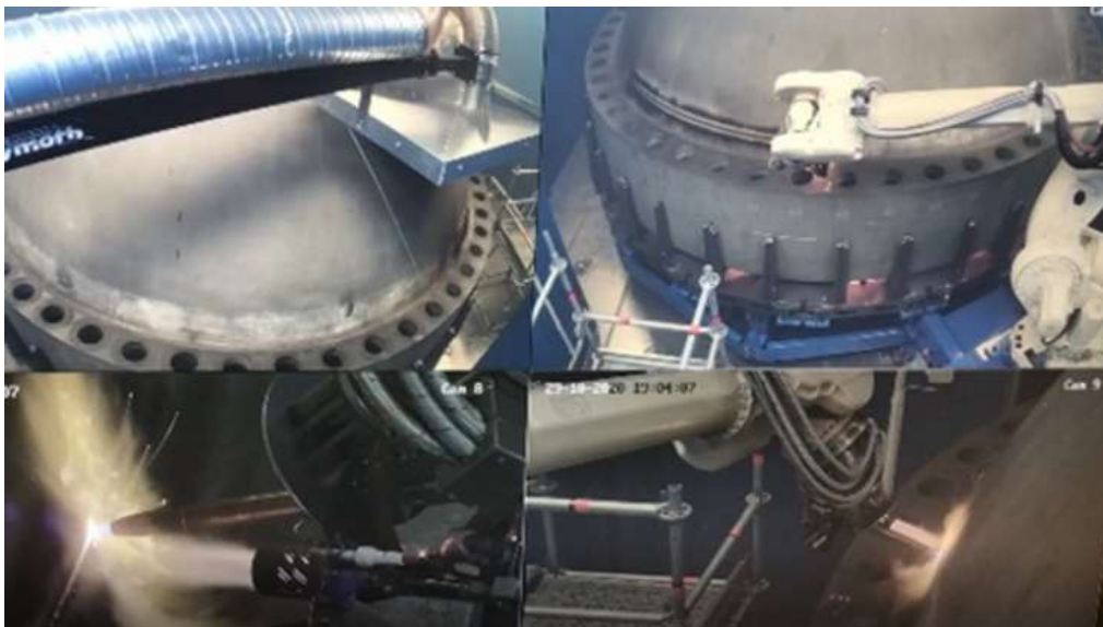
圖 1 遠端機器手臂系統切割 Barsebäck 核電廠 1 號機 RPV (資料來源：Uniper)
