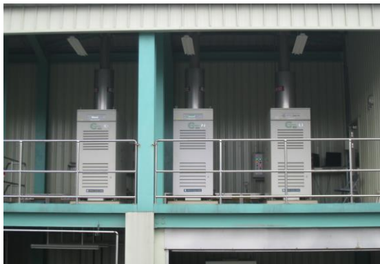
圖 10：微電網 Zone 1~Zone 3 之分散式電源建置及穩定孤島運轉測試
