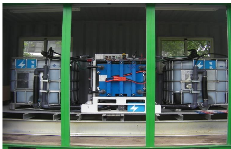
圖 22：5kW 液流電池示範系統運轉
