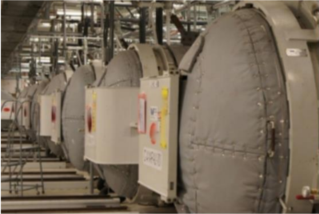
圖十一、美國六氟化鈾處理工廠加溫處理槽
