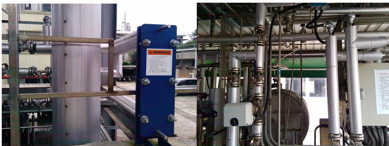
圖 c-1、增設蒸餾塔底熱回收裝置(圖左)及分子篩吸附系統
