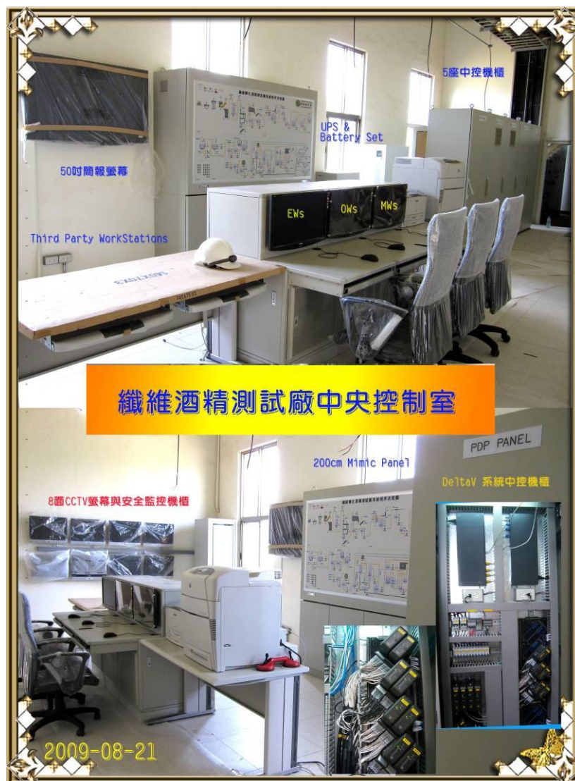
圖 1.11 中央監控系統
