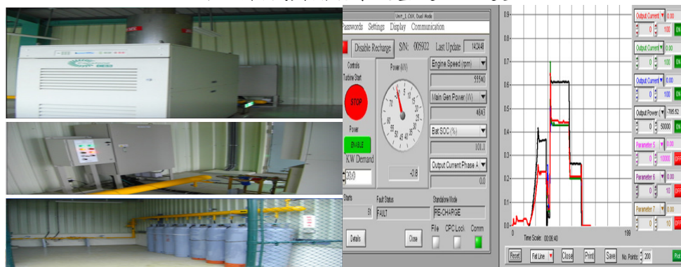
微渦輪機安裝運轉與測試
