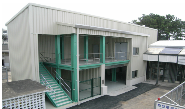
微渦輪機與儲能系統基礎設施建置
