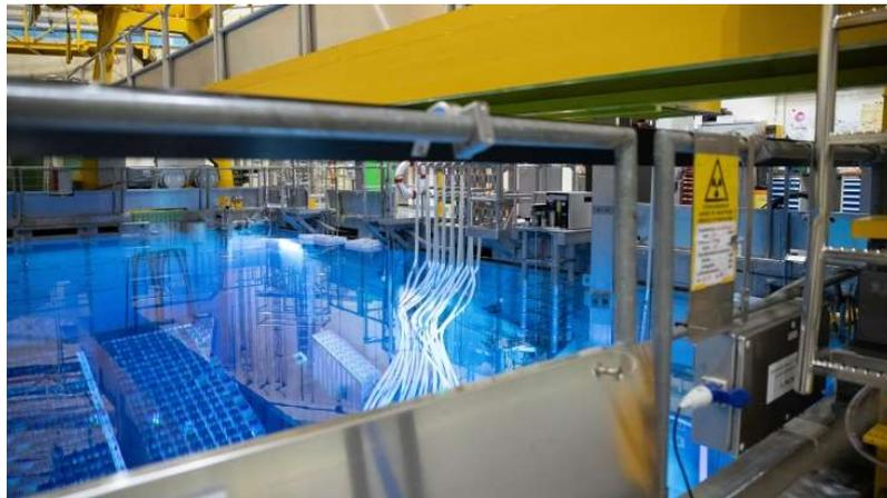
圖 1、Mühleberg 核電廠用過燃料池與新增之冷卻系統 (圖片來源：BKW)
