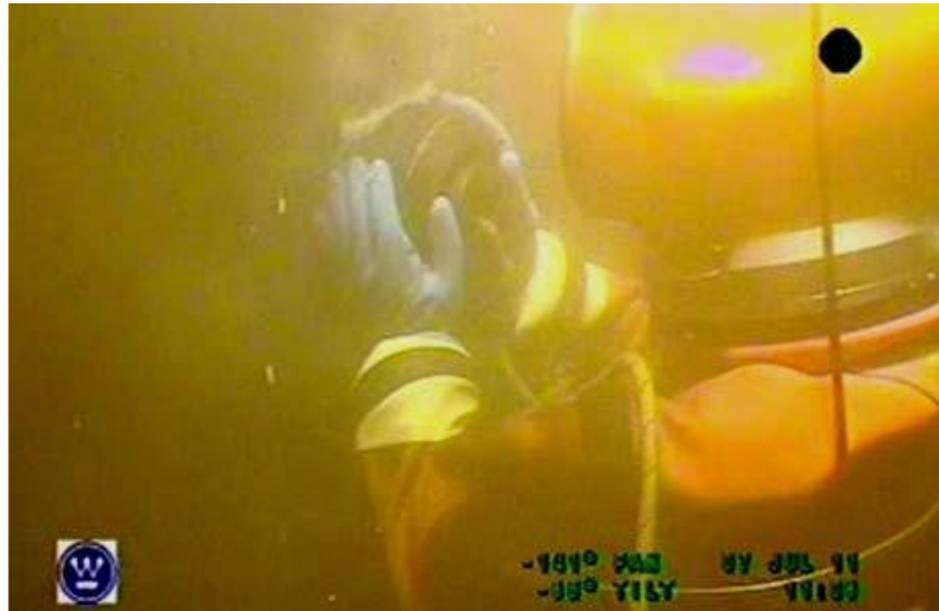
圖 3.12：潛水員執行洩漏緊固作業
