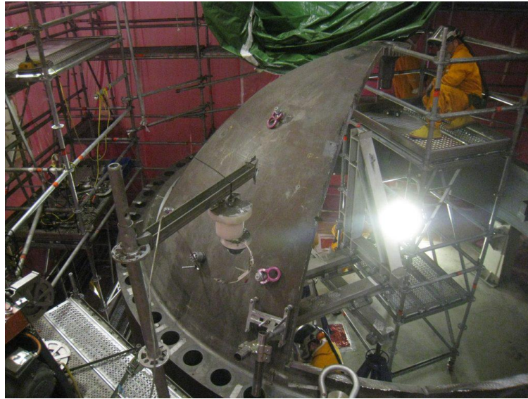
圖 3.25：工作人員切割反應器壓力槽頂蓋
