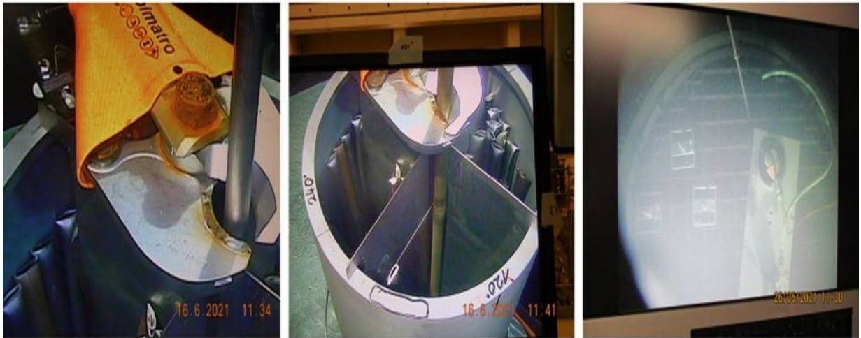
圖 3.31：利用水下液壓剪將中子通量測量探管拆解
