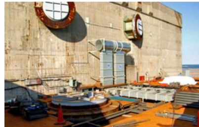
拆除熱交換器頂部的熱氣管道後
