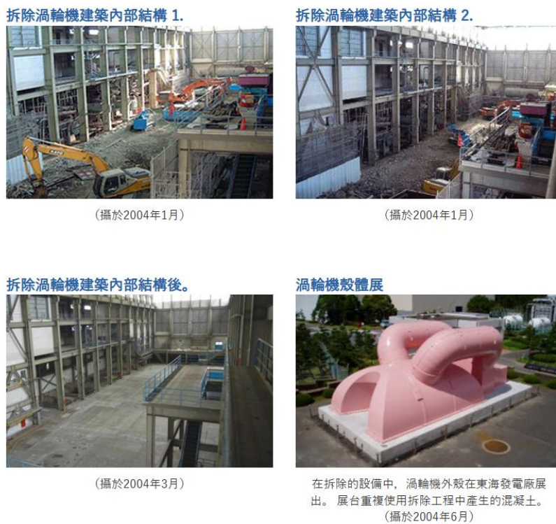
圖 2.6：東海核電廠渦輪機建築區設備拆除(摘自 JAPC 網站)
