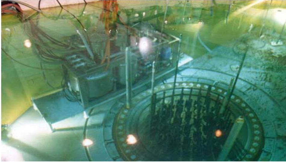
圖 3.3：池中過濾設備
