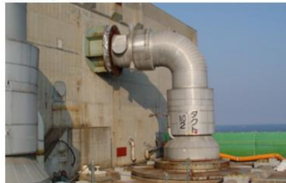
拆除熱交換器屋頂熱氣管道 (熱交換器進氣管道) 之前
