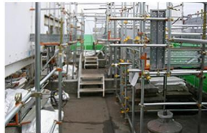
拆除屋頂設備 (安全閥、噴嘴、屋頂風扇等)
